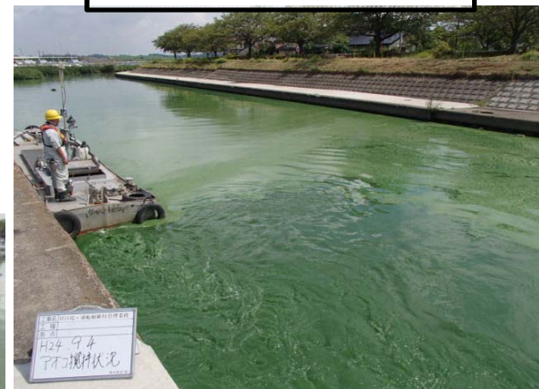
作業船によるアオコ攪拌作業⑤
