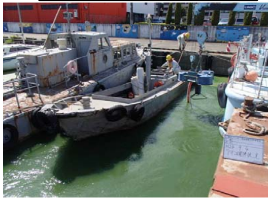
作業船によるアオコ攪拌作業②
