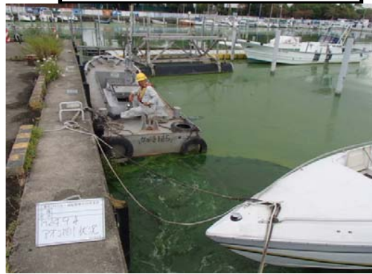
作業船によるアオコ攪拌作業③
