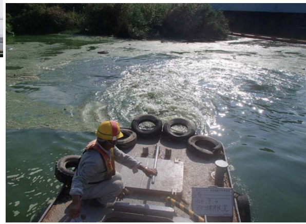
作業船によるアオコ攪拌作業⑤
