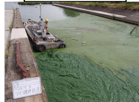
作業船によるアオコ攪拌作業⑤
