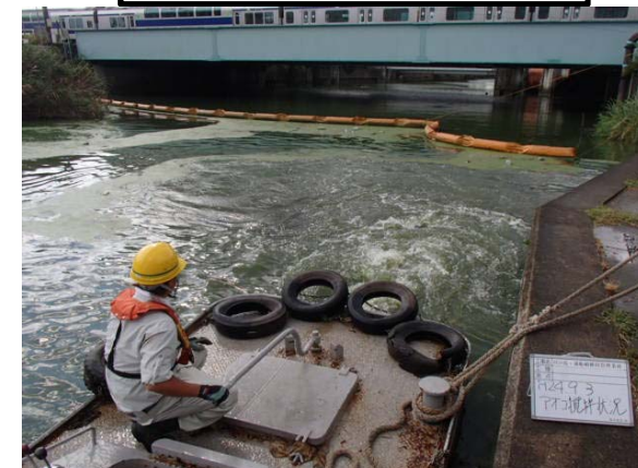
作業船によるアオコ攪拌作業⑤
