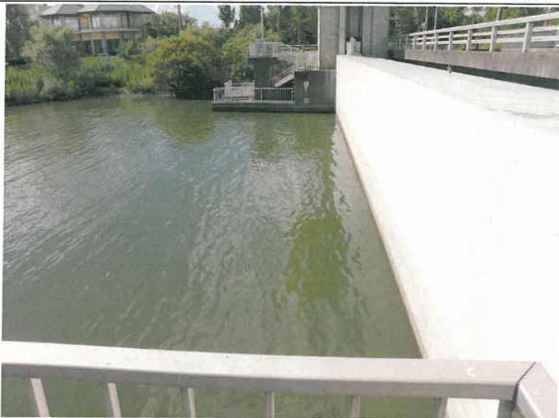
西浦右岸47.25km+50m 備前川水門表 レベル3 9:05 水門は下りていた
