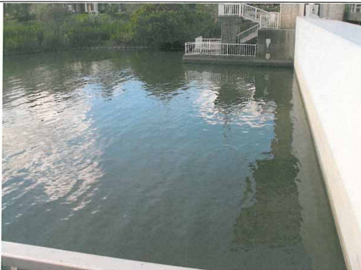
西浦右岸47.25km+50m 備前川水門表 レベル3 9:00 水門は下りていた
