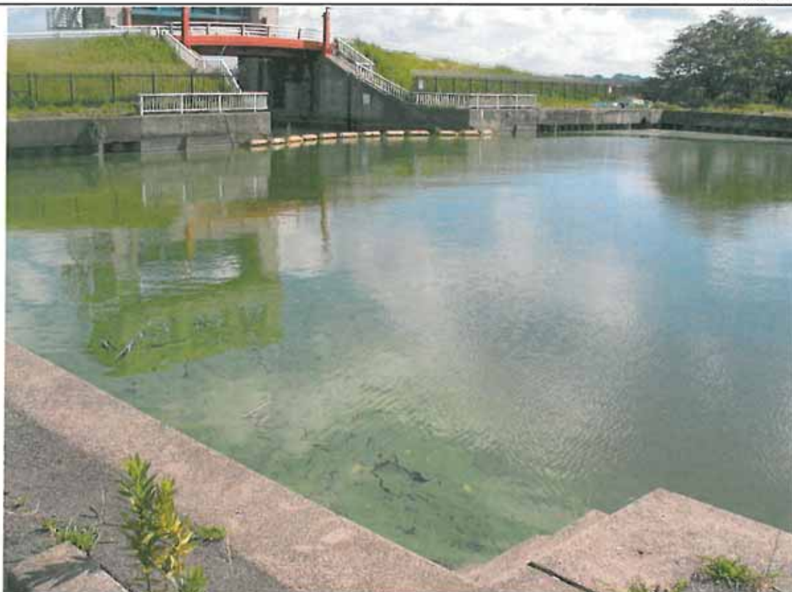
西浦右岸48.5km+100m 霞ポート レベル3~4
