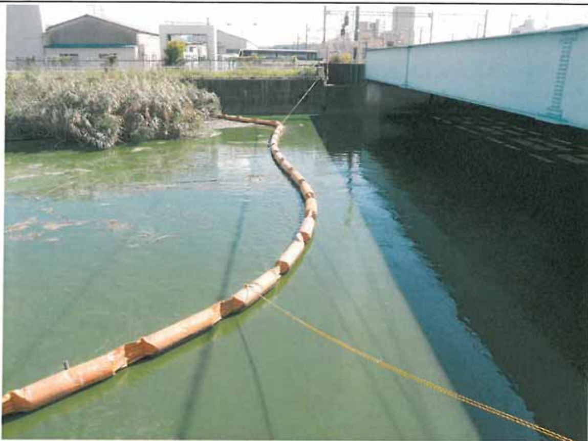
西浦中岸2.75km+40m(新川 常磐線橋梁下) レベル4 (15:00)
