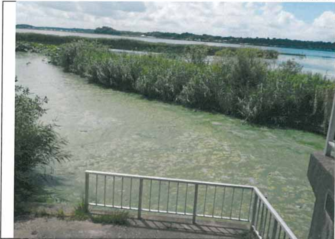
西浦左岸34km-100上高崎排水樋門前レベル6におい有り
