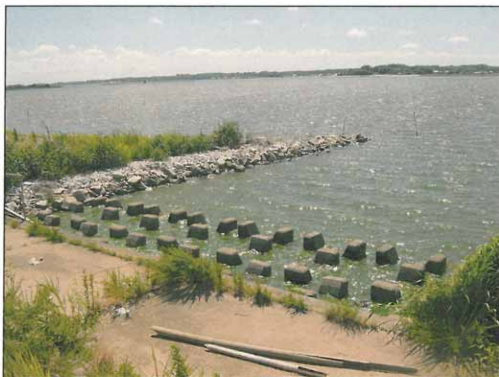
西浦左岸32.00k-50.0m付近
