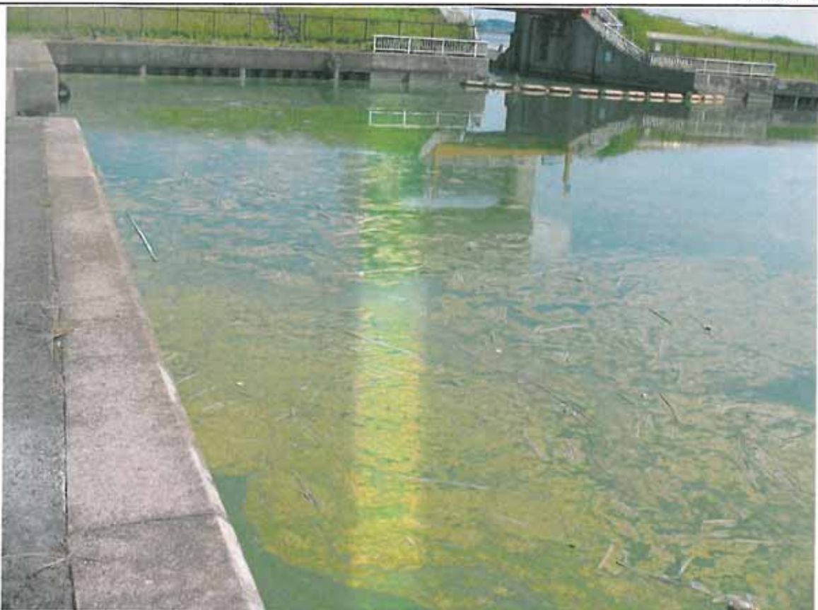
西浦右岸48.5km+100m 霞ポート レベル3~5
