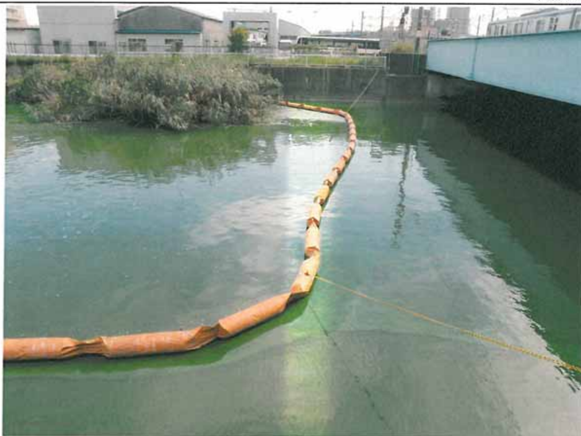
西浦中岸2.75km+40m(新川 常磐線橋梁下) レベル4 (14:50)
