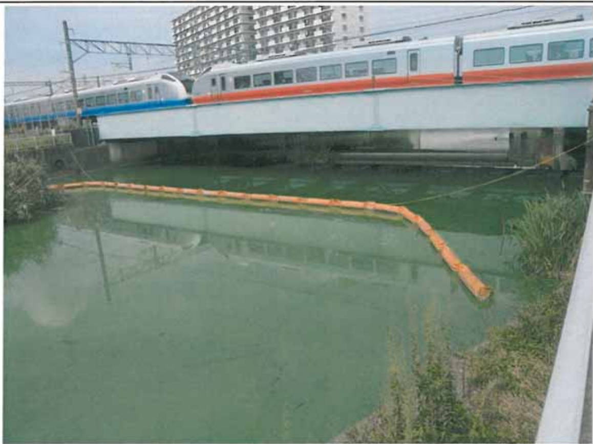
西浦中岸2.75km+40m(常磐線橋梁下) レベル5
