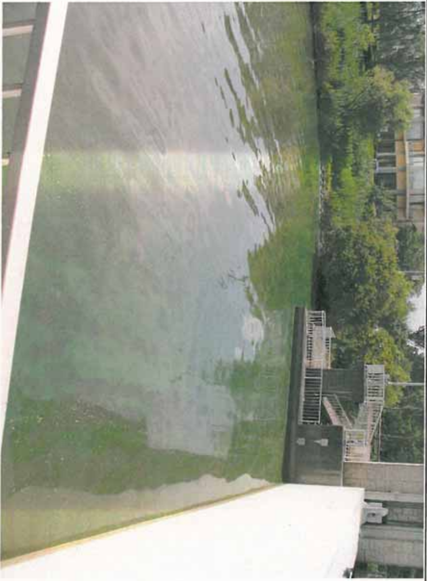
西浦右岸47.25km+50m 備前川水門表 レベル3~4(9:20) 水門は終日下りた状態
