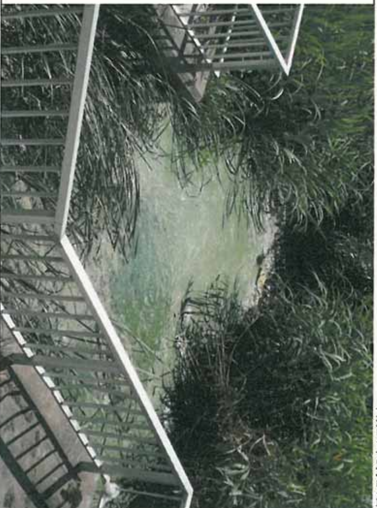
西浦左岸34km+140川島排水樋門前
