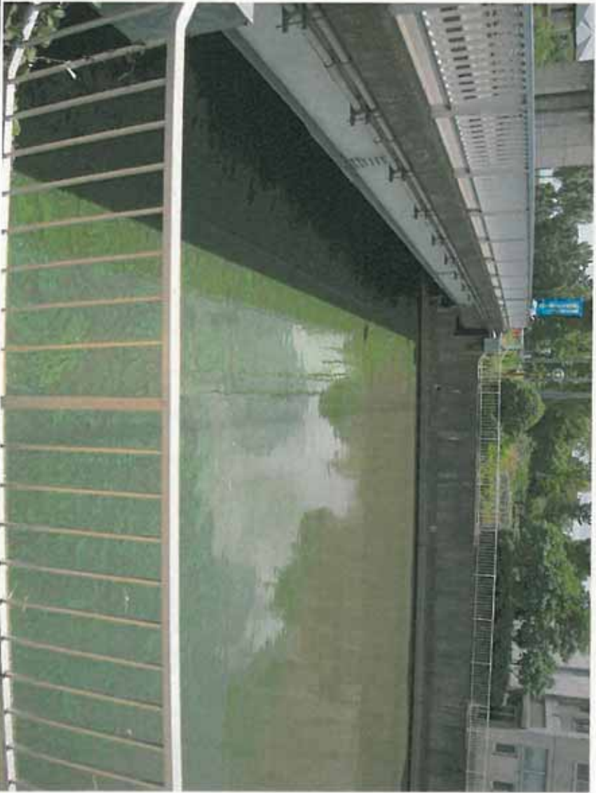
西浦右岸47.25km+50m 備前川水門裏 レベル3~4(11:15)水門は終日下りた状態
