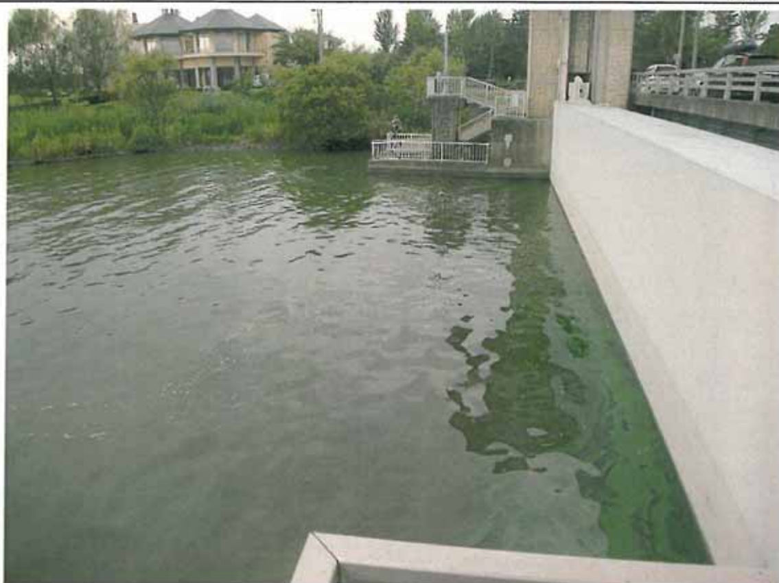
西浦右岸47.25km+50m 備前川水門表 レベル2～3(8:39) 水門は終日下りた状態
