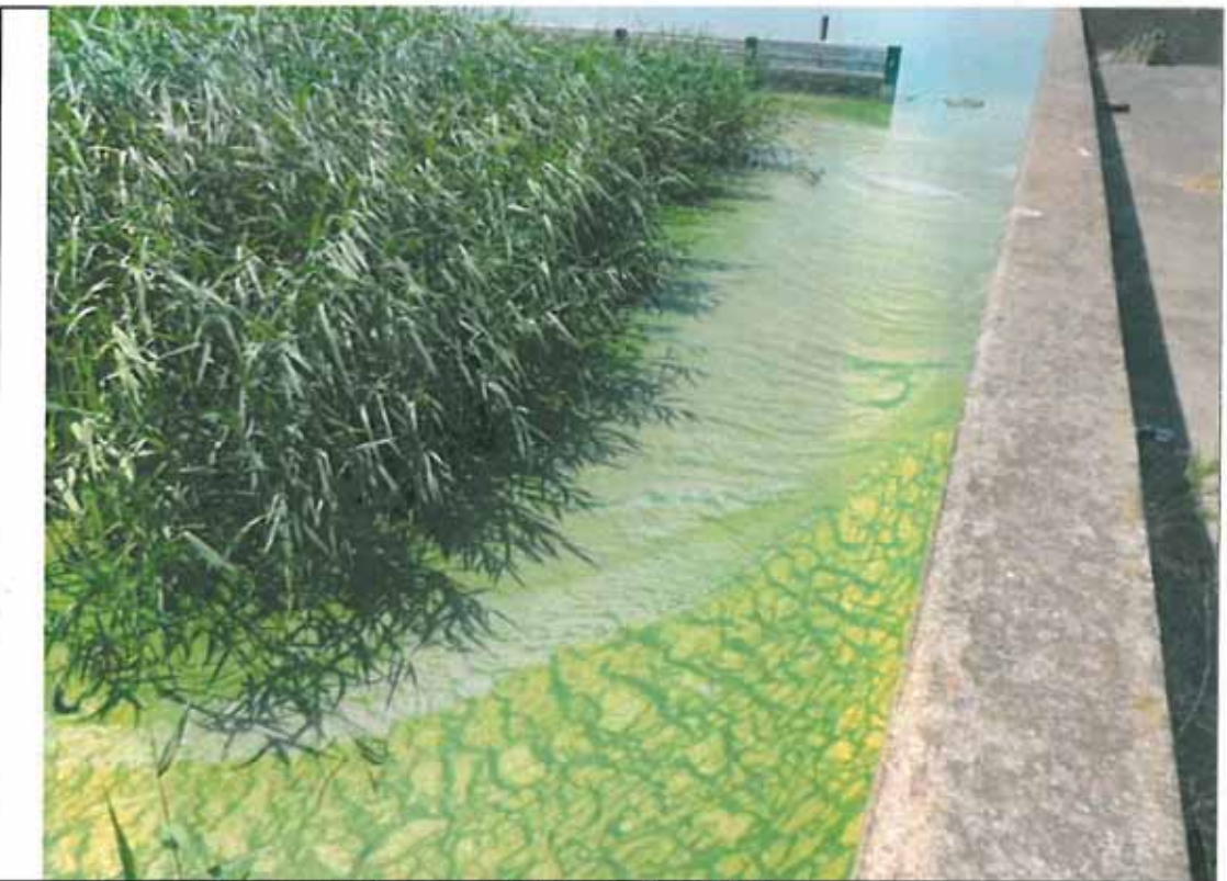
西浦左岸32.5km-30県植生帯 レベル4～5 におい有り
