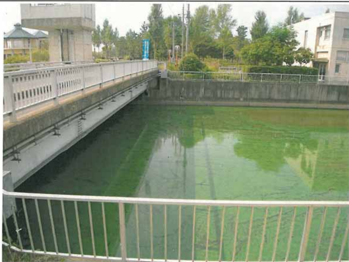
西浦右岸47.25km+50m 備前川水門裏 レベル3～4(8:39) 水門は終日下りた状態
