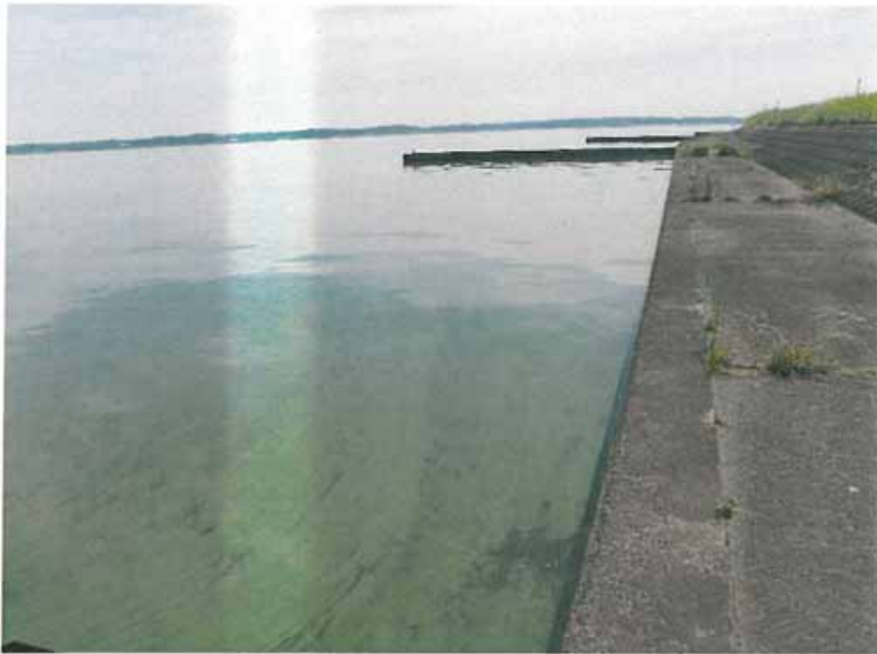
北浦右岸9km
