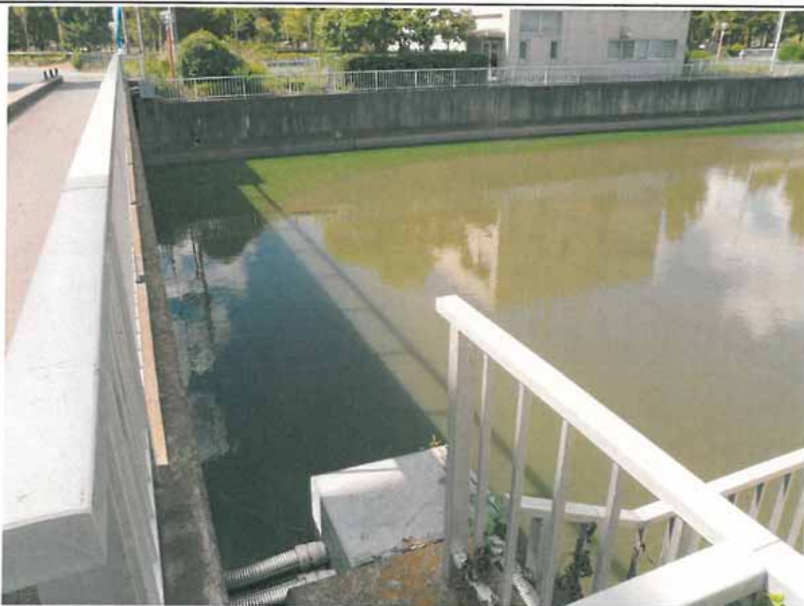
西浦右岸47.25km+50m 備前川水門裏 レベル3~4 9:05 水門は下りていた
