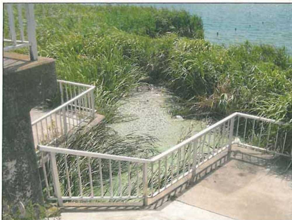
西浦左岸34.00k+145.0m(川島排水樋門前)
