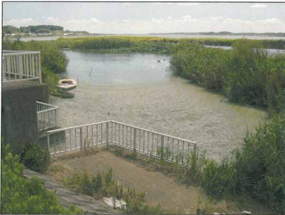
西浦左岸33.75k+110.0m(上高崎揚排水樋門前) レベル6 無臭・におい有り
