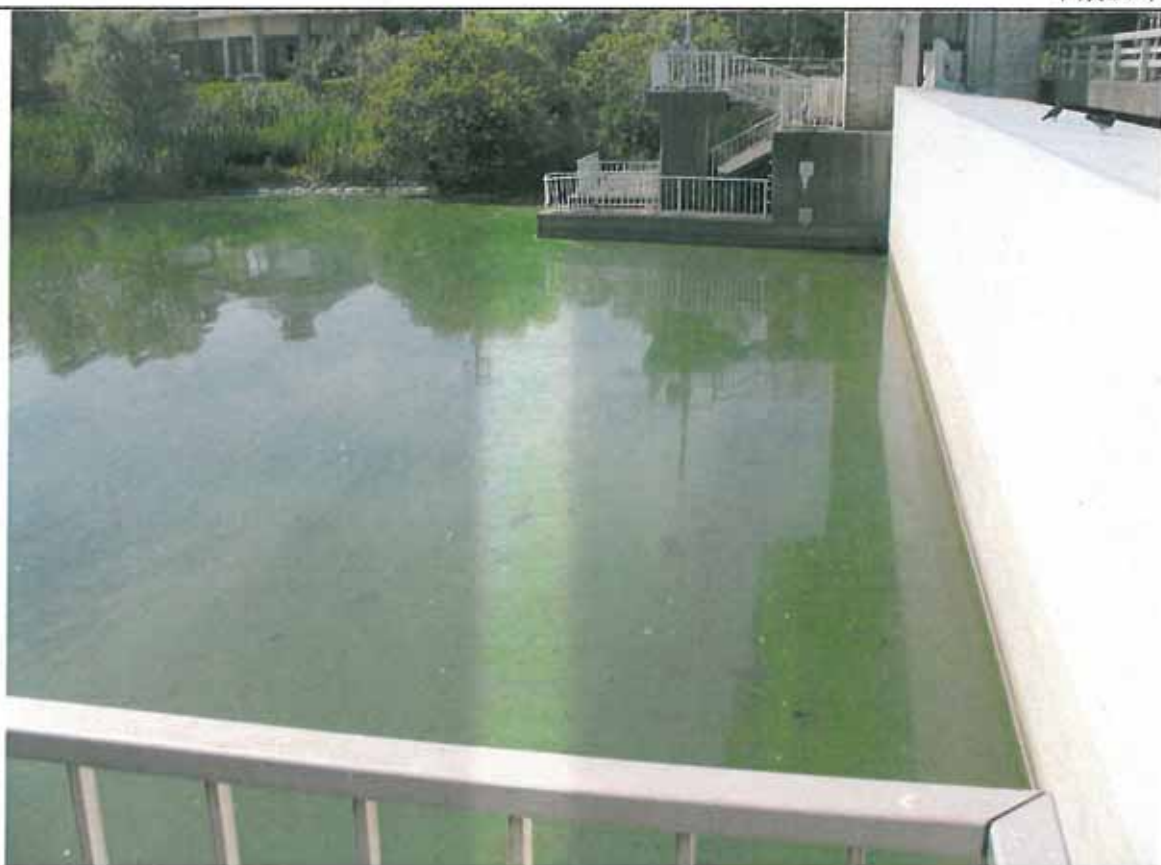
西浦右岸47.25km+50m 備前川水門表 レベル4 9:15 水門は下りていた
