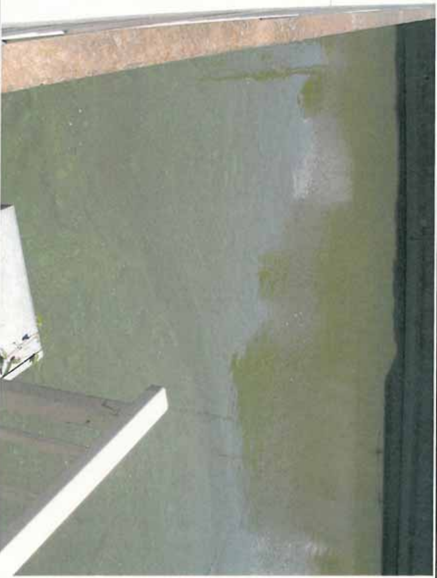
西浦右岸47.25km+50m 備前川水門裏 レベル3～4 13:10 水門は下りていた
