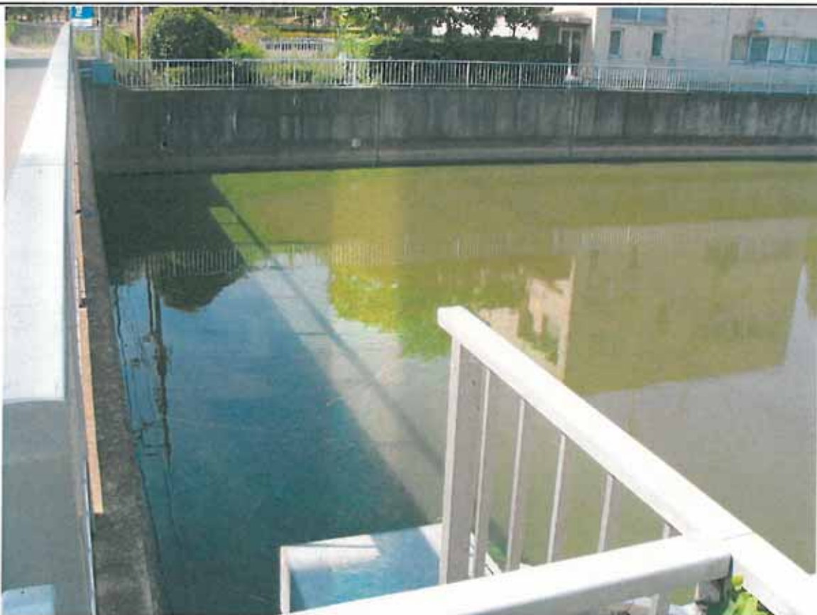
西浦右岸47.25km+50m 備前川水門裏 レベル3~4 9:15 水門は下りていた
