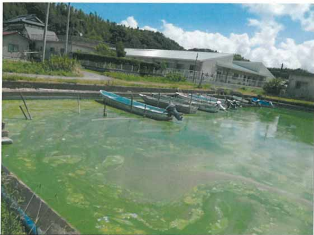
西浦左岸33km+100上高崎舟溜り レベル5～6におい有り
