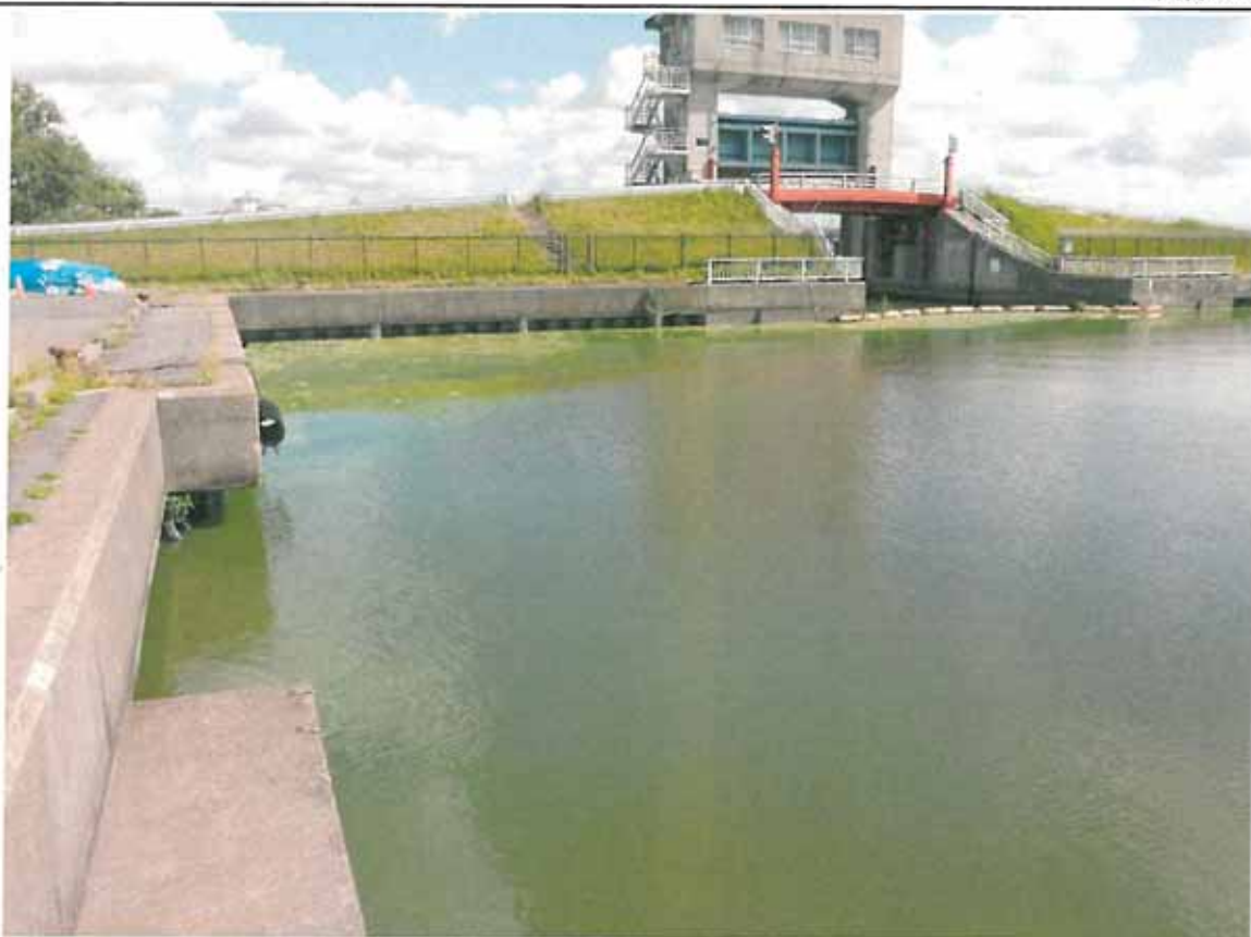
西浦右岸48.5km+100m 霞ポート レベル4～5
