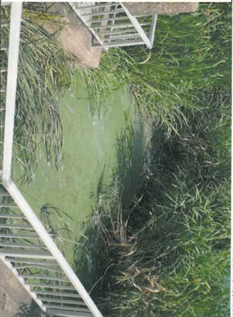
西浦左岸34km+140川島排水樋門前
