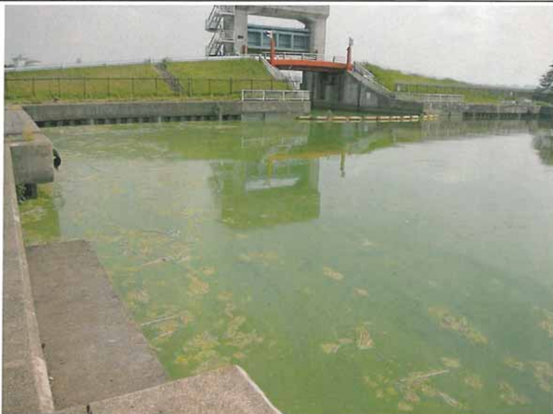
西浦右岸48.50km+100m(霞ポート)レベル3~4(8:32)
