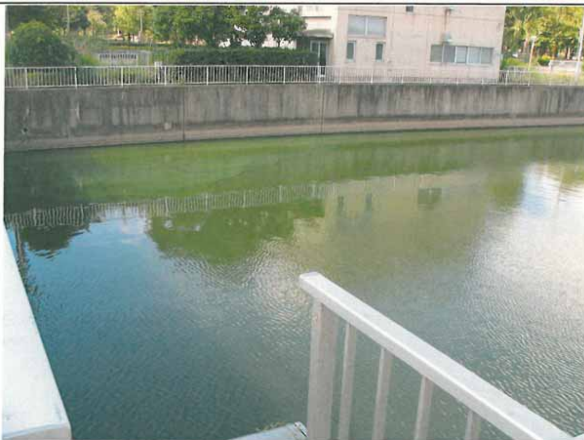
西浦右岸47.25km+50m 備前川水門裏 レベル3～4 9:00 水門は下りていた
