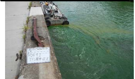
作業船によるアオコ攪拌作業⑥
