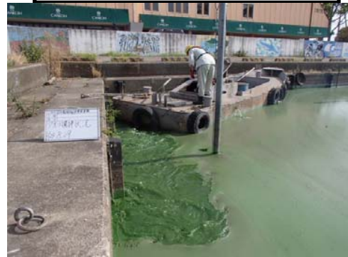
作業船によるアオコ攪拌作業②
