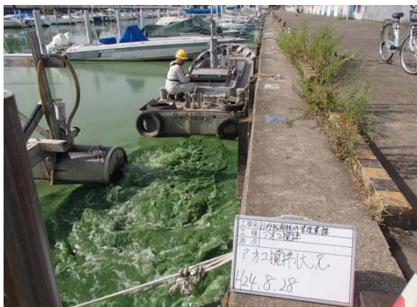
作業船によるアオコ攪拌作業②
