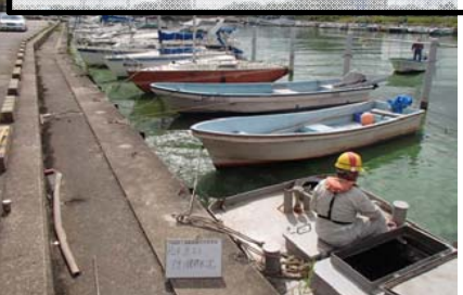
作業船によるアオコ攪拌作業③
