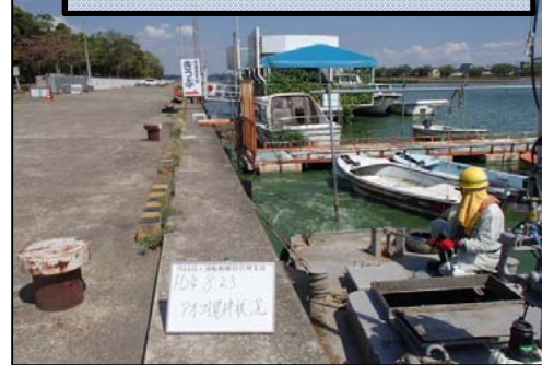
作業船によるアオコ攪拌作業④
