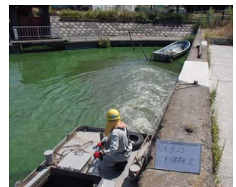
作業船によるアオコ攪拌作業⑤
