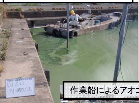
作業船によるアオコ攪拌作業②
