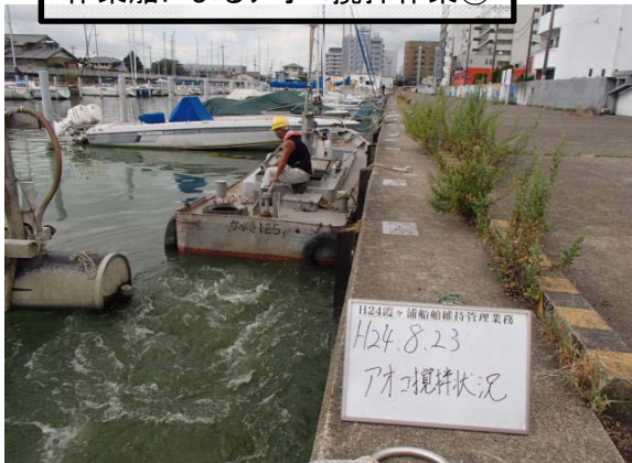
作業船によるアオコ攪拌作業②
