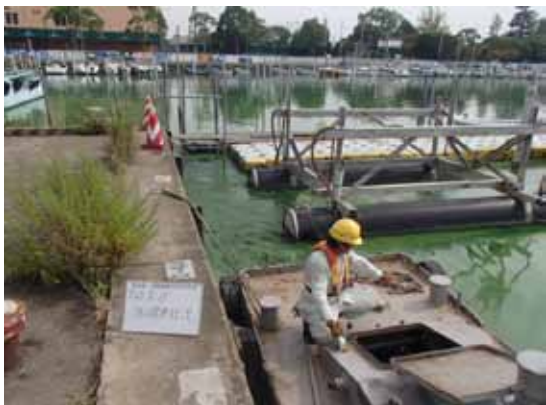
作業船によるアオコ攪拌作業
