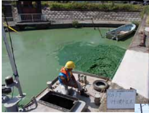
作業船によるアオコ攪拌作業
