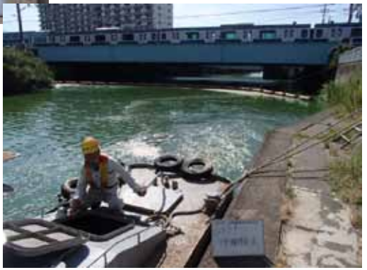
作業船によるアオコ攪拌作業
