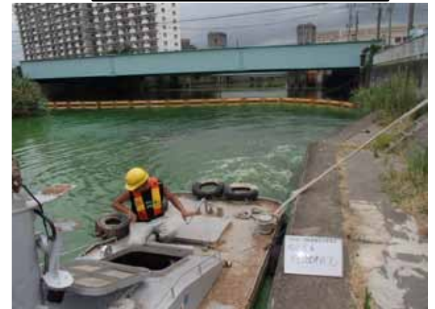
作業船によるアオコ攪拌作業
