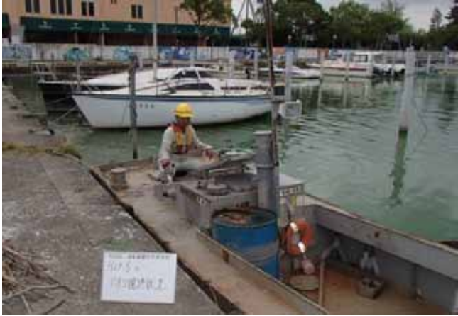
作業船によるアオコ攪拌作業
