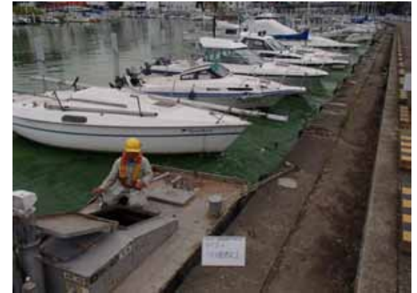
作業船によるアオコ攪拌作業
