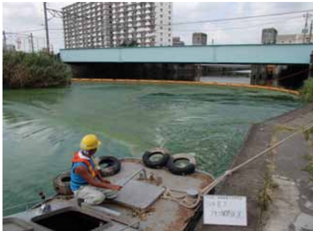
作業船によるアオコ攪拌作業
