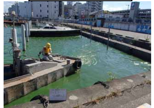
作業船によるアオコ攪拌作業
