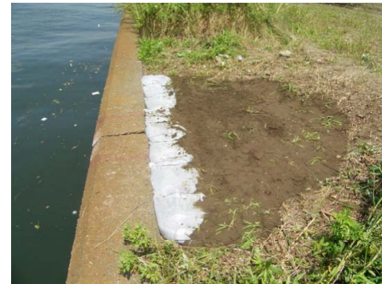
土と土のうにより補修。
