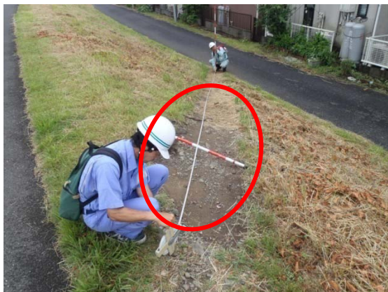
堤防法面の踏み跡を確認。
