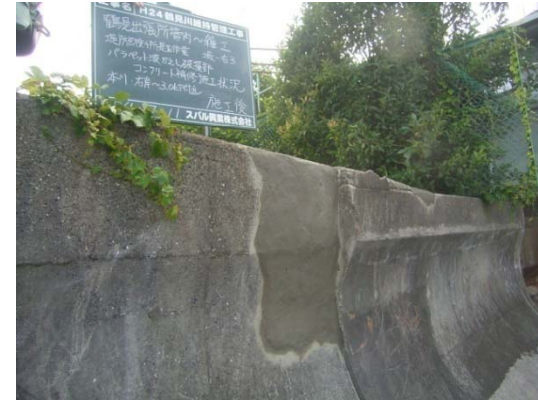
堤防護岸の表面をモルタルで補修。
