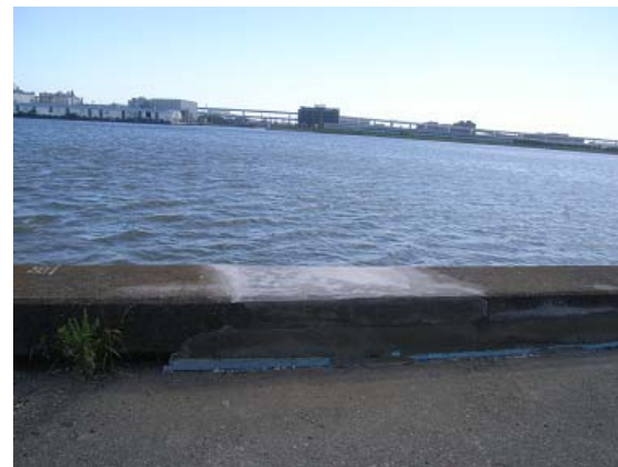
コンクリートで補修。
