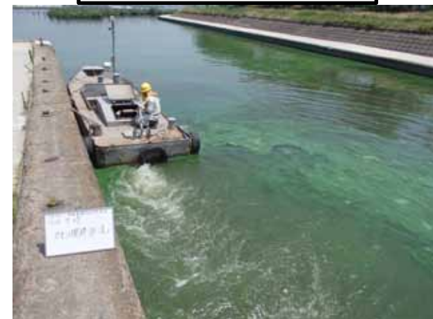
作業船によるアオコ攪拌作業
