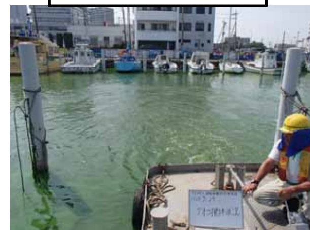
作業船によるアオコ攪拌作業
