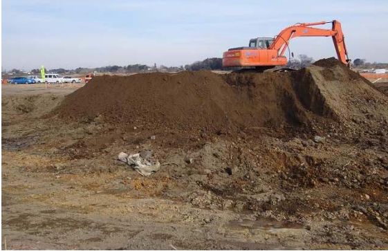
平成24年1月19日現在の施工状況
