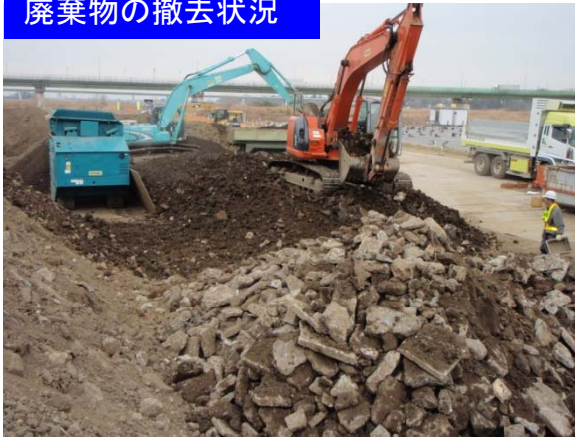
廃棄物の撤去状況
