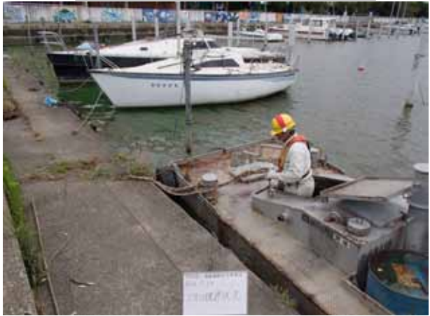
作業船によるアオコ攪拌作業
