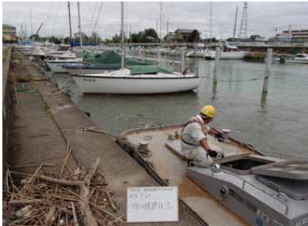
作業船によるアオコ攪拌作業
