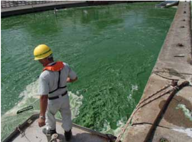
作業船によるアオコ攪拌作業
