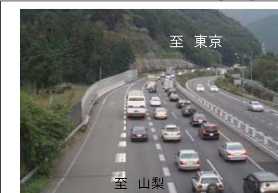
①小仏トンネル付近
