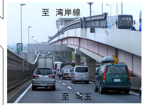
⑤中央環状線 堀切JCT付近
