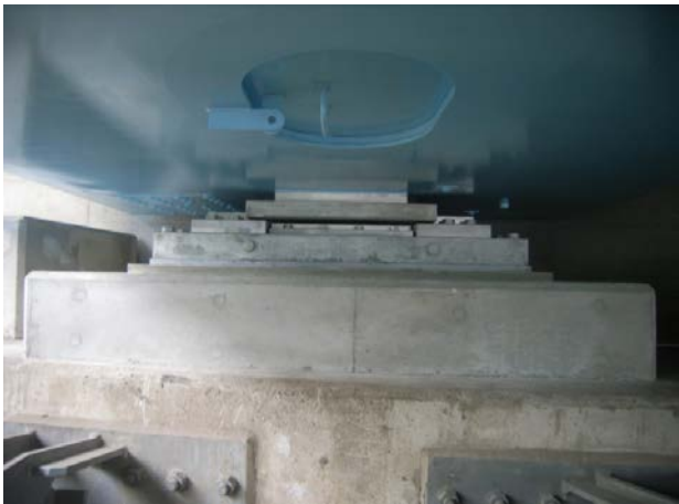
支承取替後状況
