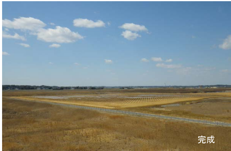
完成又は施工状況写真
