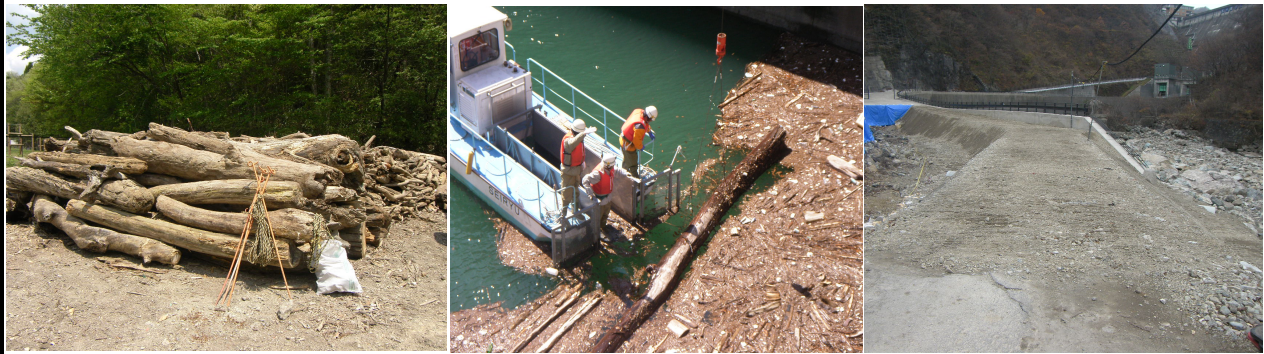
完成又は施工状況写真
