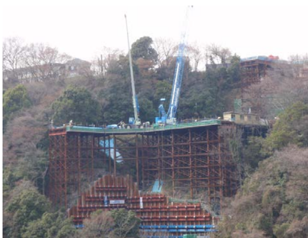
完成又は施工状況写真
