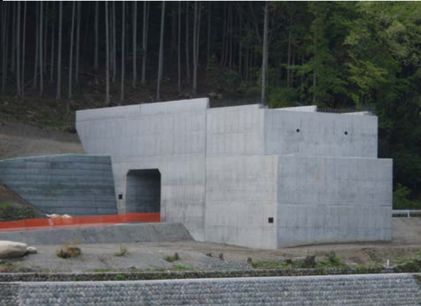
完成又は施工状況写真
