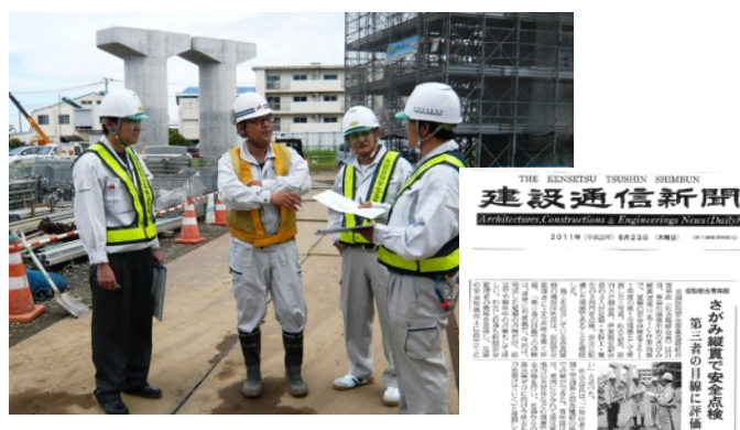
安全管理(第三者による現場点検)
