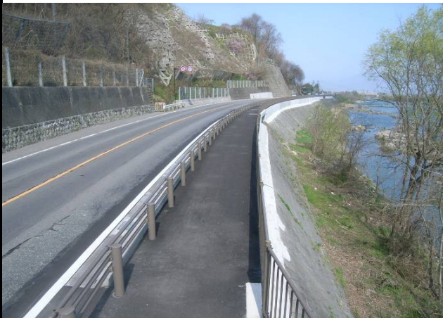
完成又は施工状況写真 【完成】
