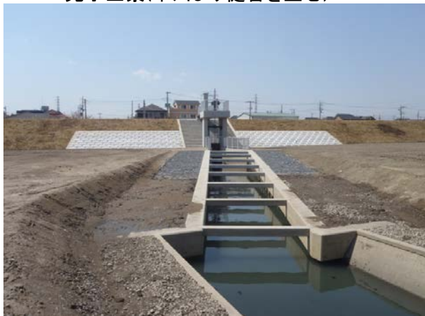
完了全景(中川より樋管を望む)
