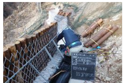
間伐材擁壁組み立て状況
