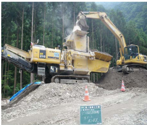
ソイルセメント攪拌作業状況
