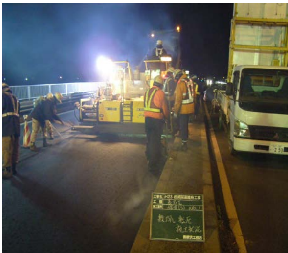
完成又は施工状況写真
