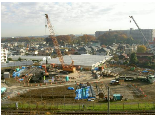
施工中写真(H23.7)
