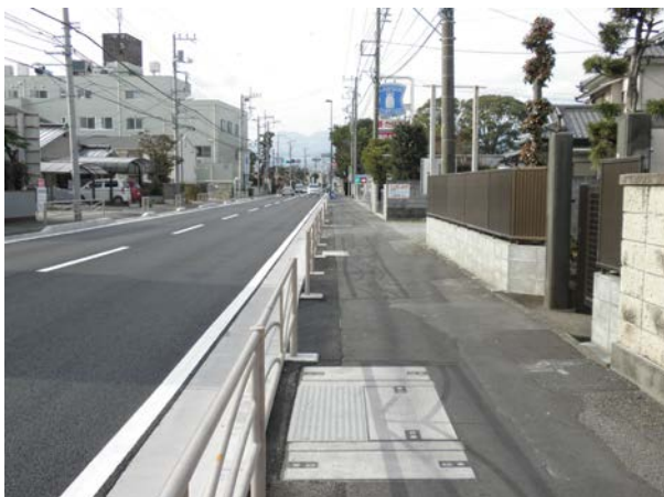
完成又は施工状況写真
