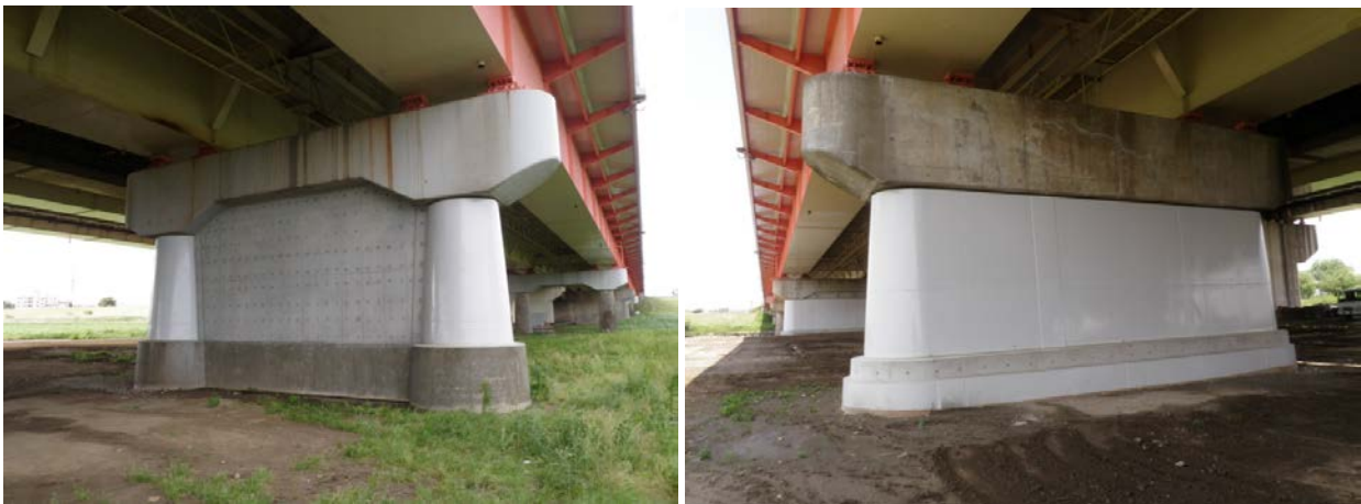
完成又は施工状況写真
