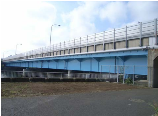
補修後完成状況
