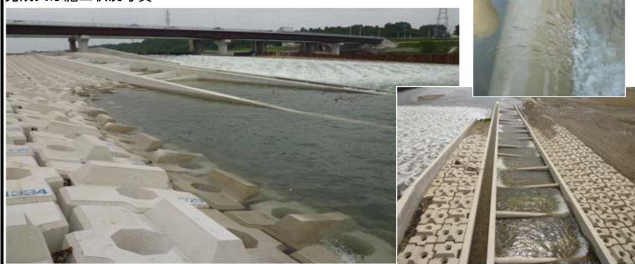
完成又は施工状況写真
