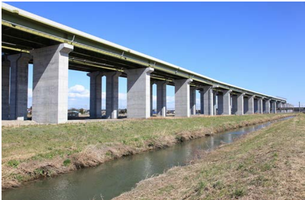
完成又は施工状況写真
