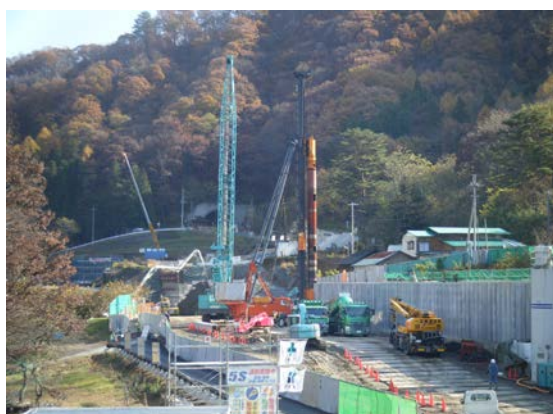
施工状況写真
