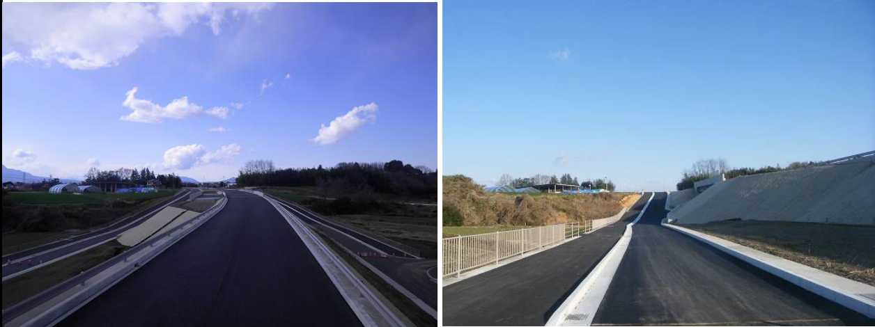
完成又は施工状況写真
