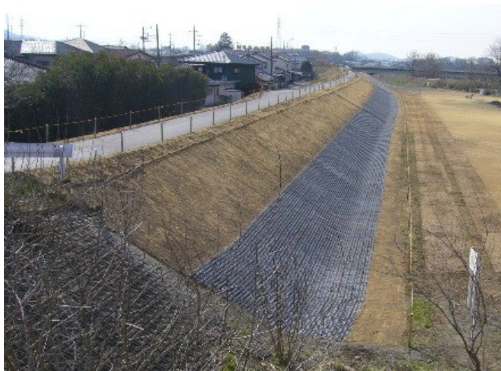
完成又は施工状況写真
