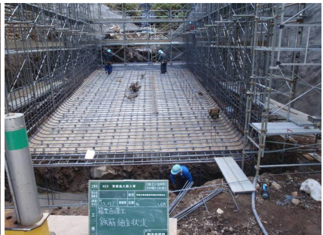
施工状況写真
