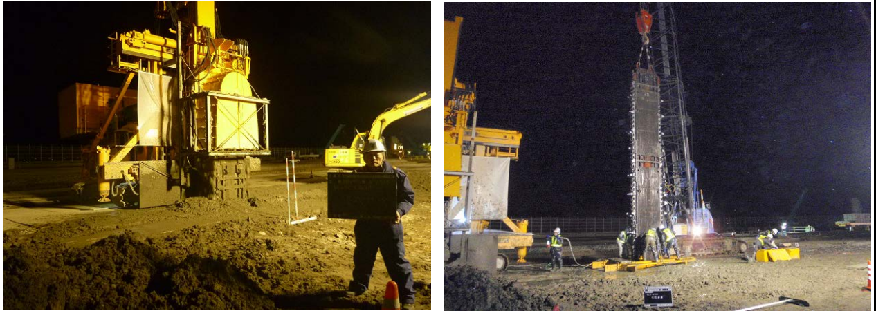
(連続地中壁造成状況)
