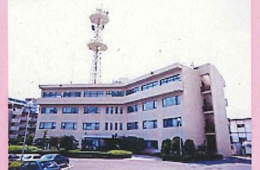
京浜河川事務所外観
