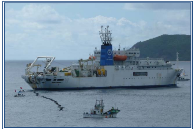
船尾から母島にケーブル陸揚げ風景
