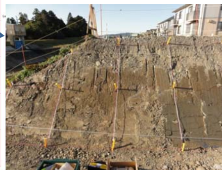
堤防上半開削面状況
