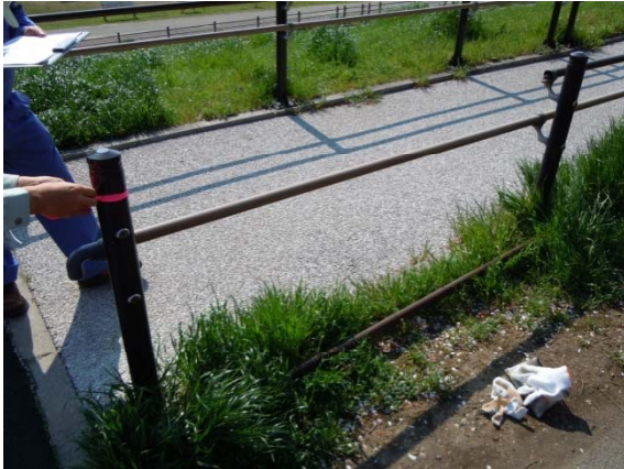
坂路の手摺りが触っただけで脱落してしまう箇所を発見しました。
