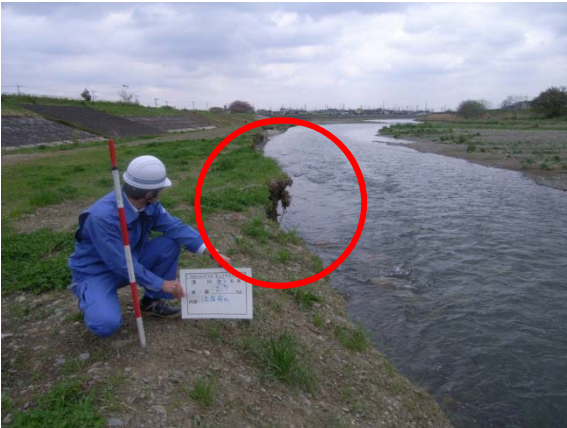
河岸が崩れ、危険な箇所を発見しました。
