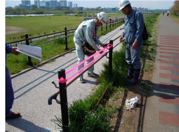
その場で応急措置としてテープを巻き、注意喚起措置を行いました。
