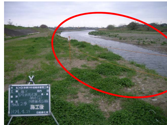
近づくると危険なため、周辺にロープを張り立入り防止措置を実施しました。
