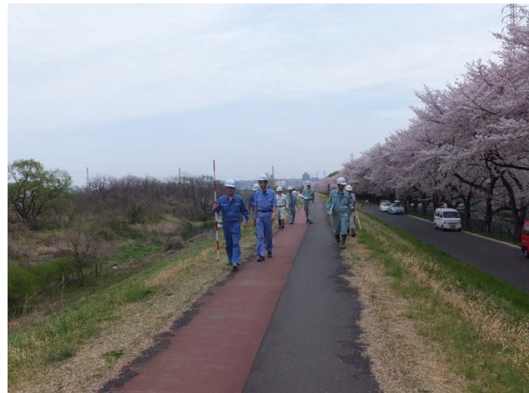
堤防に危険な箇所がないか徒歩で点検(多摩川)
