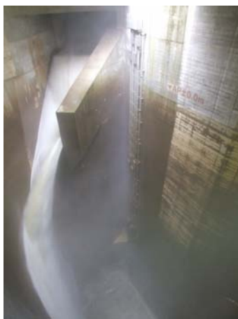
第3立坑流入状況
