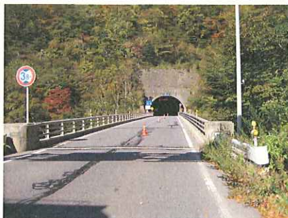
三国トンネル（群馬側坑口）
