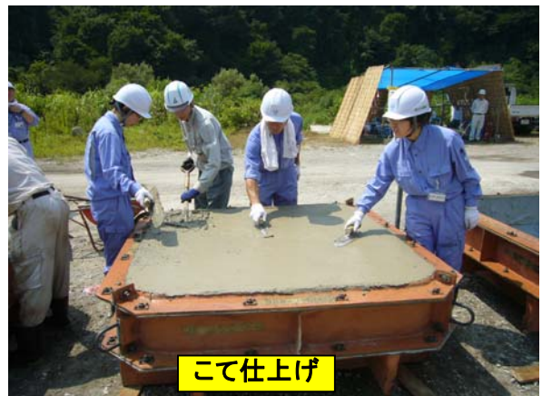
コンクリート打設
