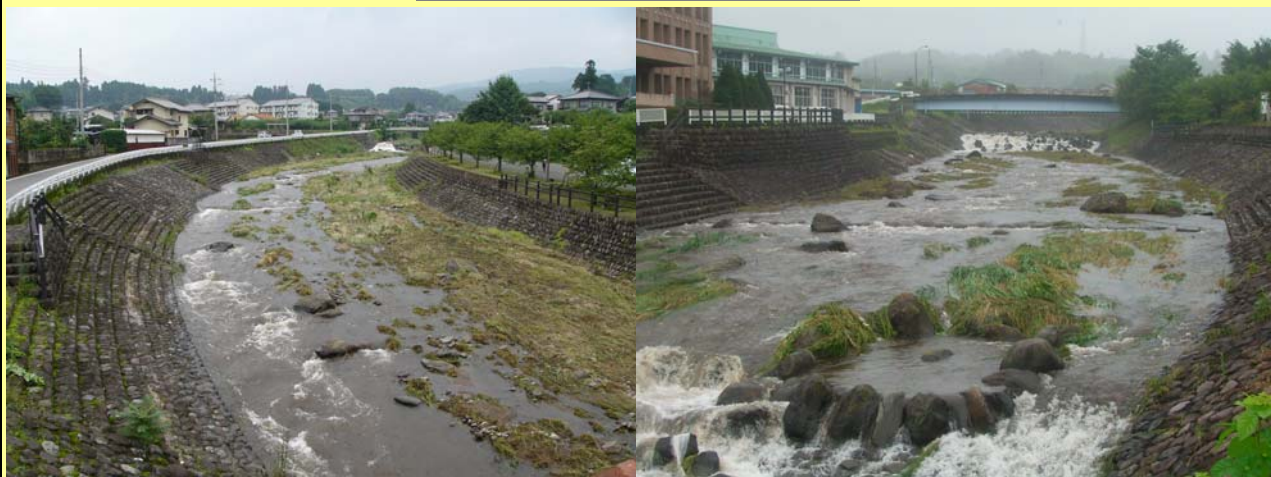
なぎ倒された河床の草
