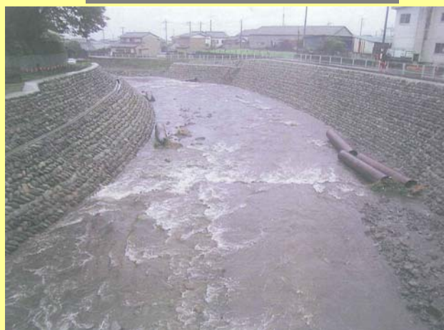
下流に流された仮排水管
