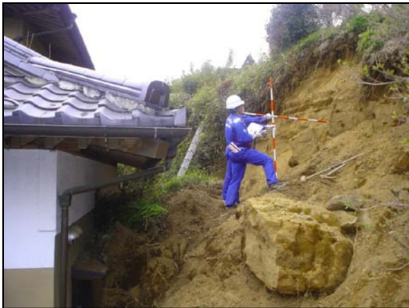
緊急点検～人家裏の斜面崩壊～
