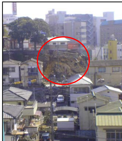
緊急点検～陥没により生じた斜面上部の段差～
