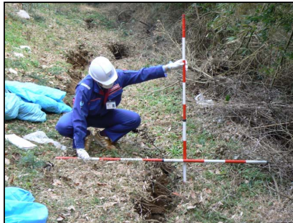
緊急点検～斜面上部に発生した亀裂（クラック）～
