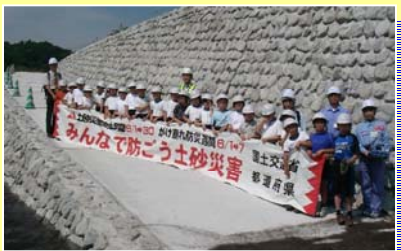
大前第十一床固工事現場にて
