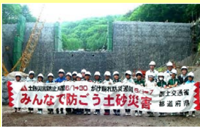
谷沢川第四砂防堰堤工事現場にて
