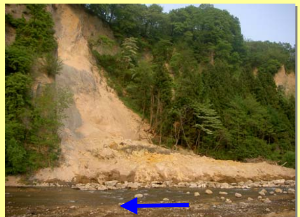
応急対策完了後 搬出土砂量は4,250m 3
