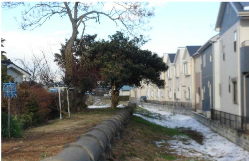
志木市宗岡地区は以前、輪中堤で洪水を防いでいました。佃堤もその一部で上流南畑地区から流下する洪水流を防ぐ目的で築かれたと言われています。
