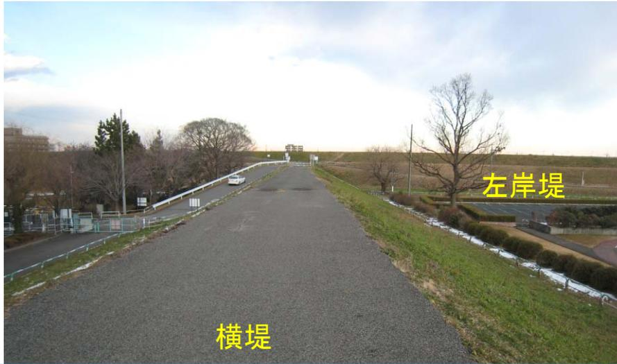
荒川の特徴である横堤は、堤防より直角に築いた堤防で、これにより遊水効果を高めている。
