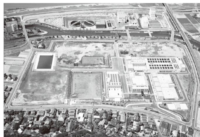
江戸川から取水し浄水場を経て各家庭へ＝ちば野菊の里浄水場
