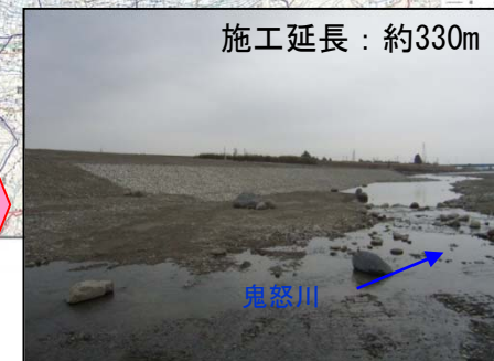
事業実施後(上平護岸整備)
