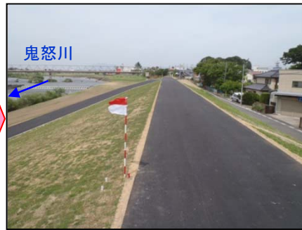
事業実施後(本町築堤) 施工延長：約520m
