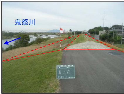
事業実施前(本町築堤)
