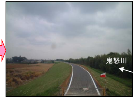
事業実施後(中妻築堤) 施工延長：約280m
