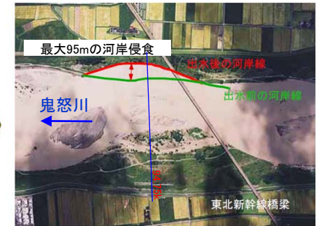
平成13年9月出水の状況 東北新幹線橋梁付近（鬼怒川）
