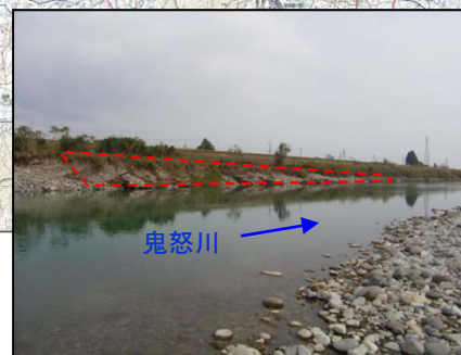
事業実施前(上平護岸整備)
