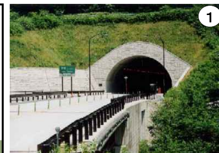
安房トンネル(高山側抗口)
