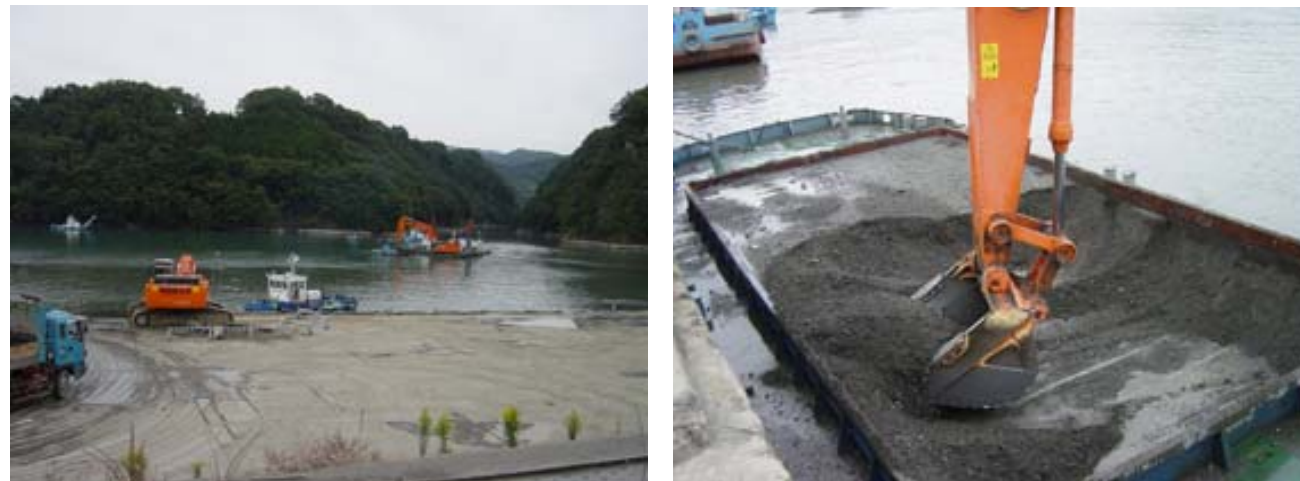
図 2.12 浚渫の状況 (H15 年 10 月)
