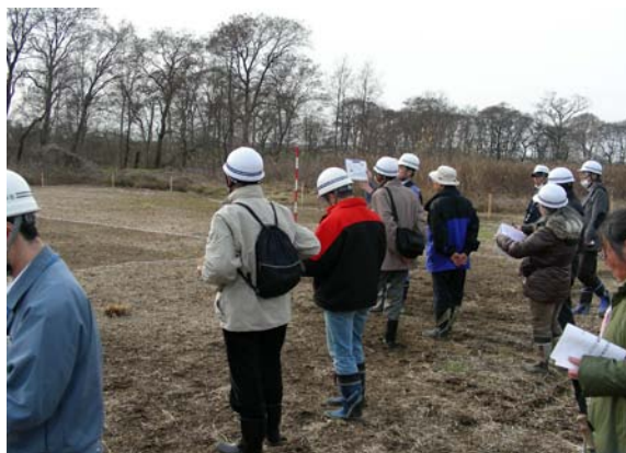
現地における確認
