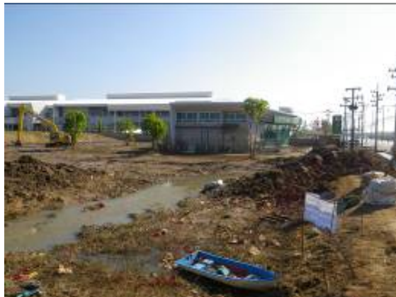
排水後の状況(11月27日)
