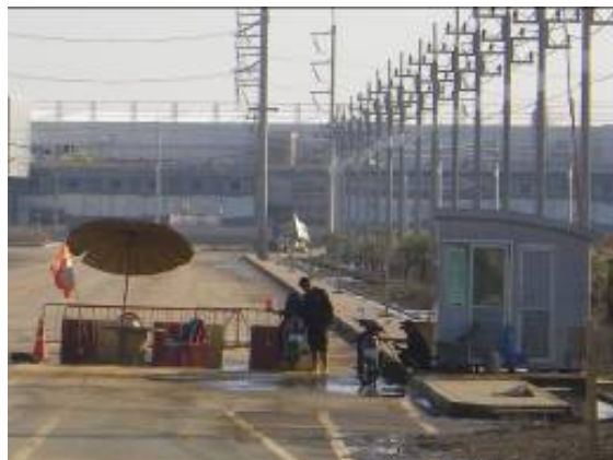
排水後の状況(11月26日)
