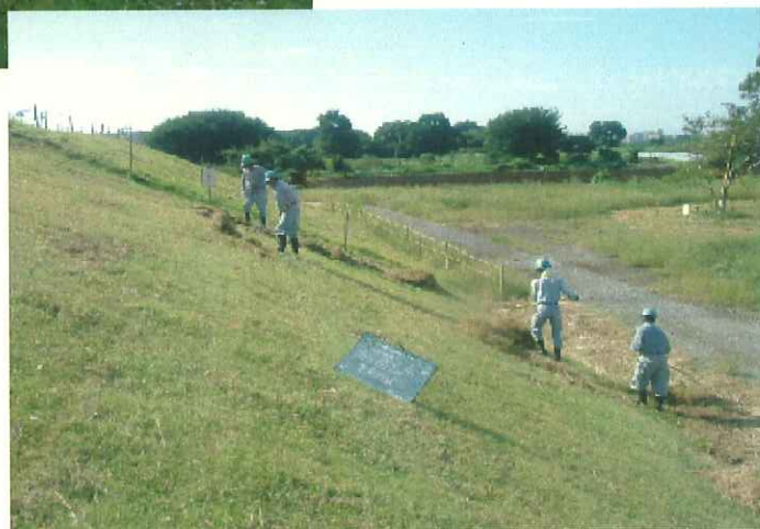
【除草後の集草状況】
