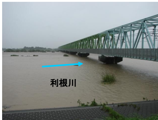
写真 2-2-17 出水状況（利根川） 埼玉県久喜市（旧栗橋町）
