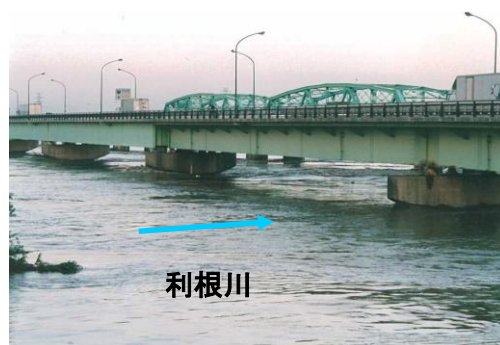
写真 2-2-16 出水状況（利根川） 埼玉県久喜市（旧栗橋町）
