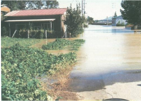
写真 2-2-13 千葉県野田市の浸水状況
