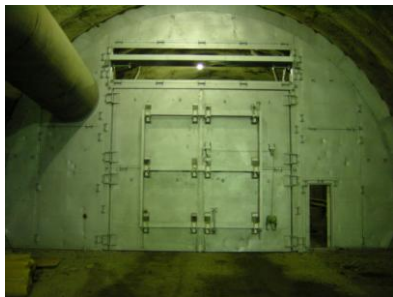
写真 3-2-3 防音扉の状況
