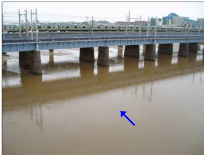
JR東海道本線橋付近
