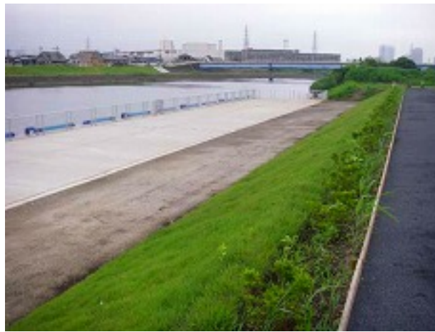
整備された駒岡防災船着き場
