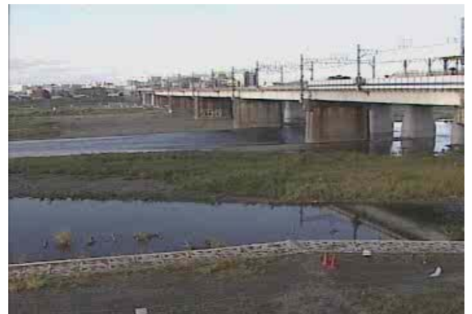
二子玉川地先(世田谷区) 平常時
