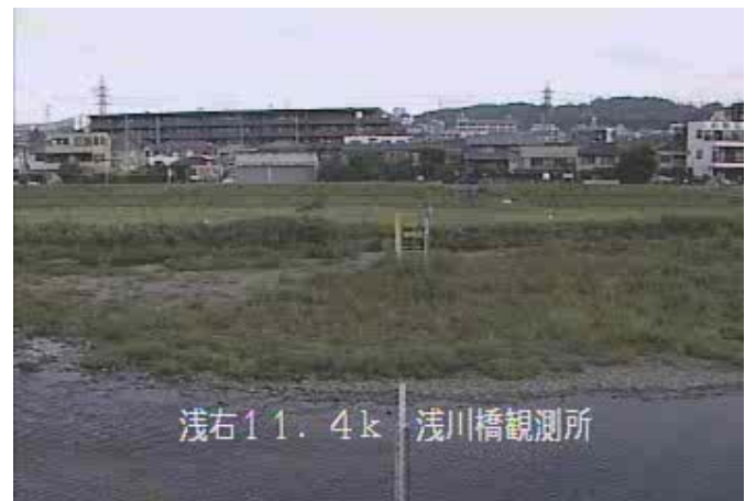
浅川橋(八王子市) 平常時
