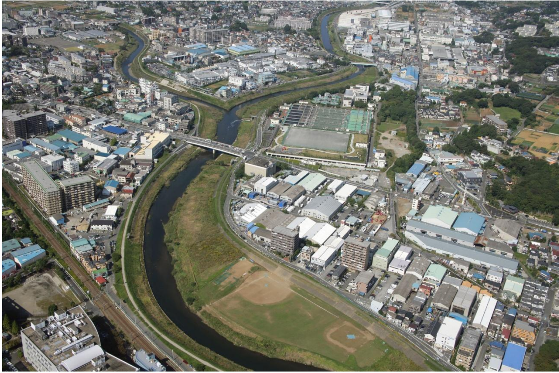
河口から 22km 付近
