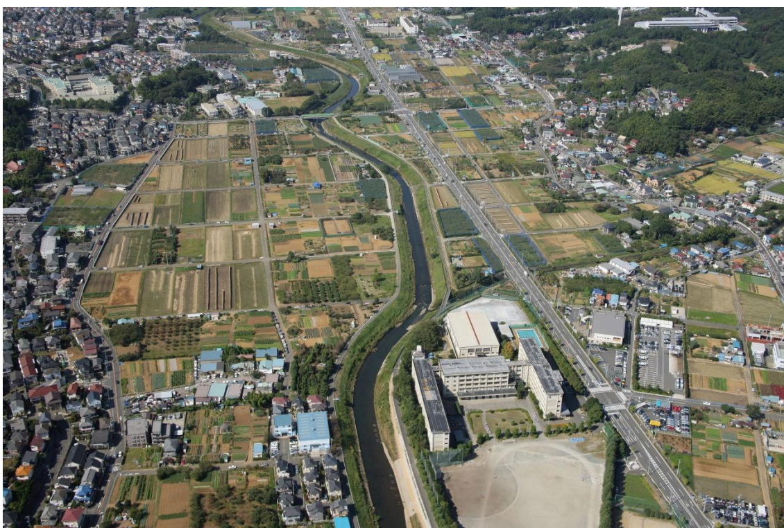
河口から 28km 付近
