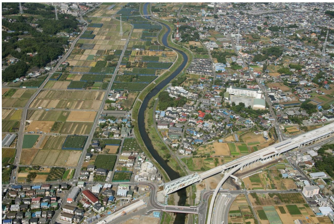
河口から 24km 付近
