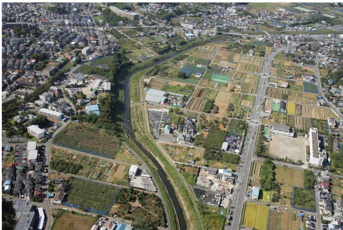
河口から 29km 付近
