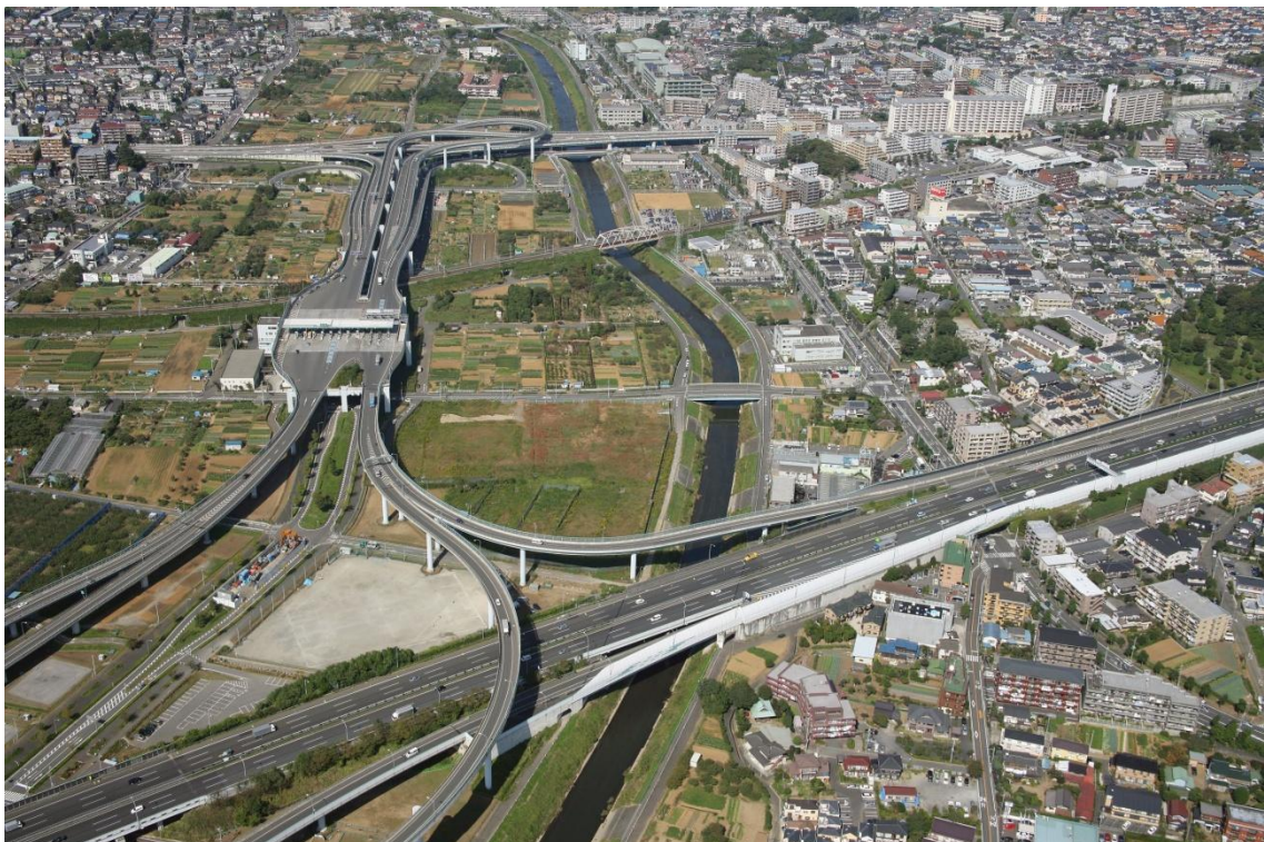
河口から 26km 付近
