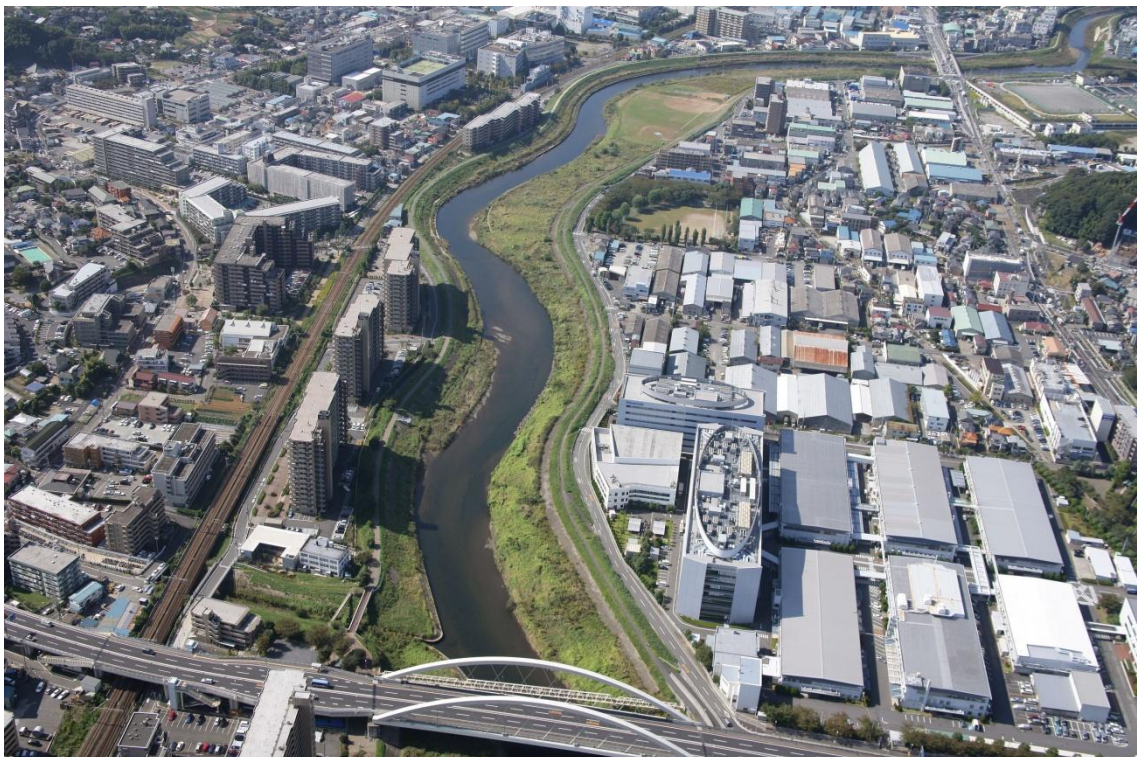
河口から 21km 付近
