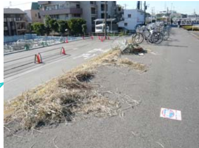
鶴見川堤防天端に飛散している刈草
