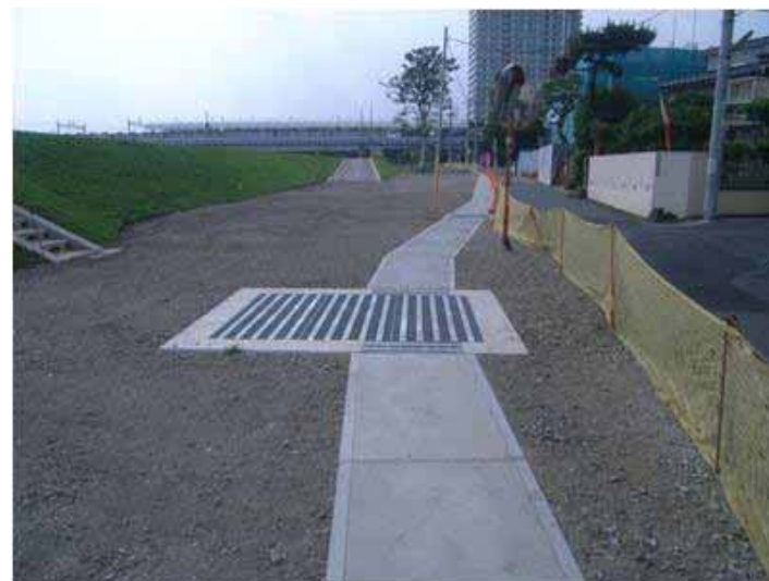
＜排水樋管に接続された排水路＞
