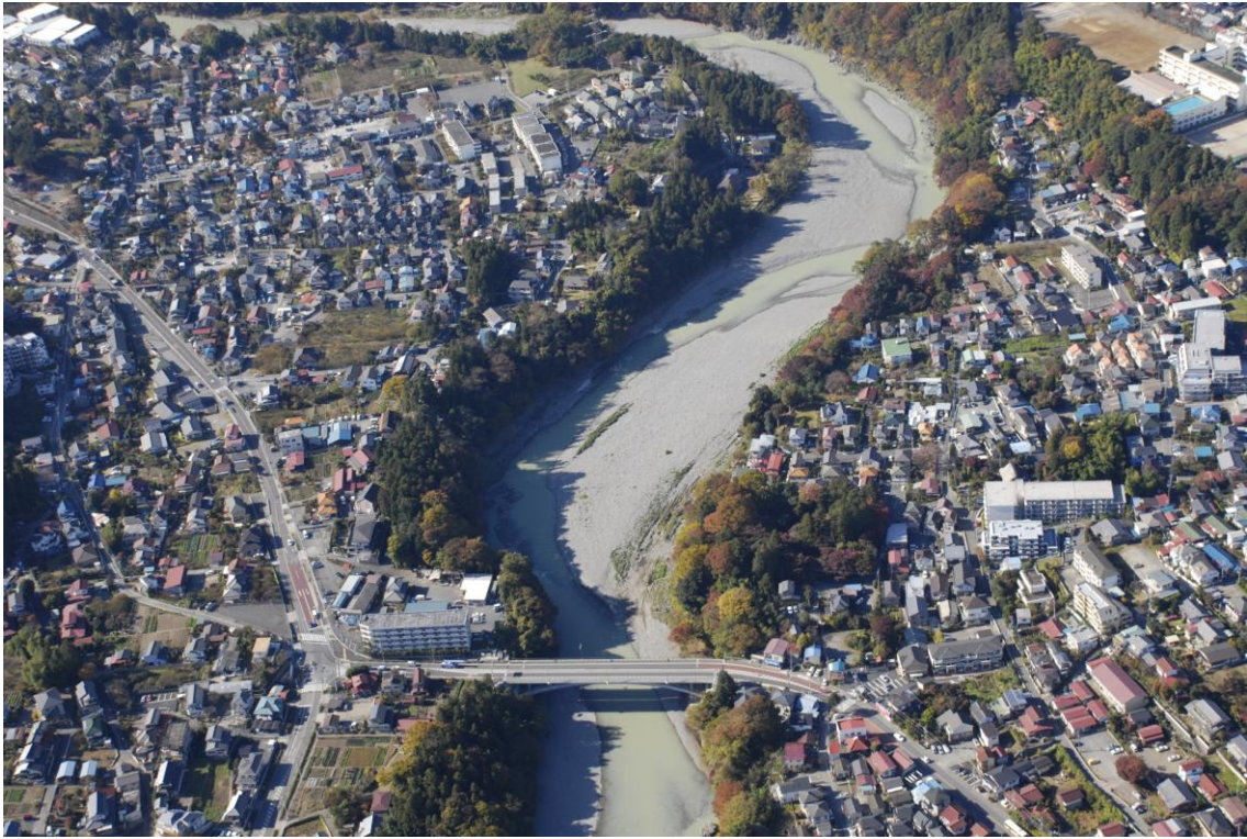
河口から 62km 付近
