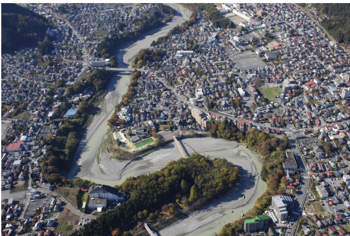
河口から 61km 付近
