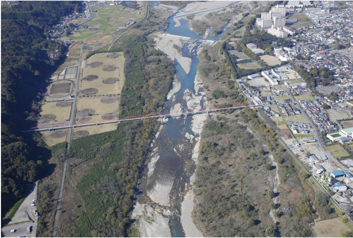
河口から 47km 付近
