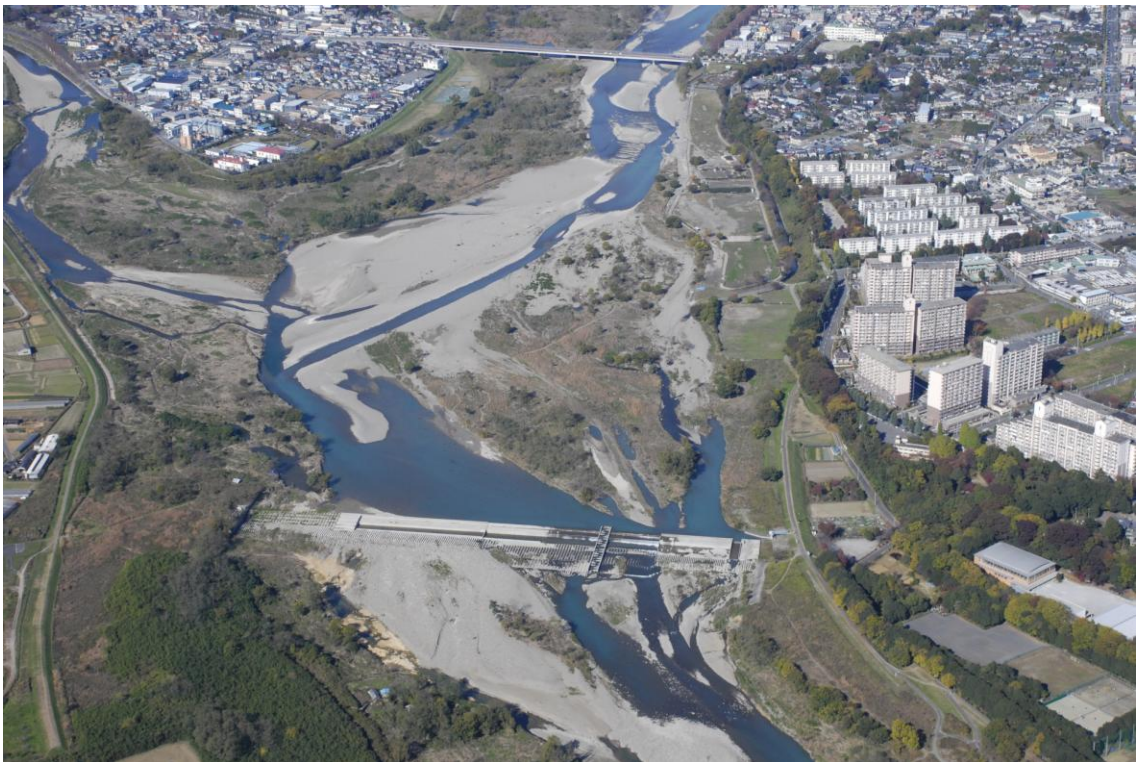
河口から 48km 付近
