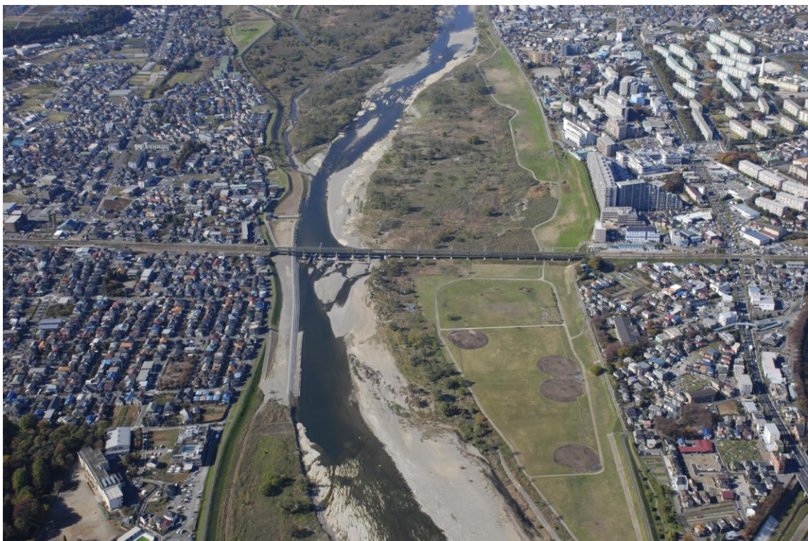
河口から 41km 付近
