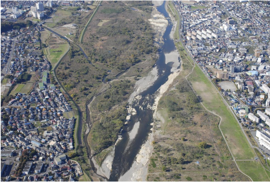
河口から 42km 付近
