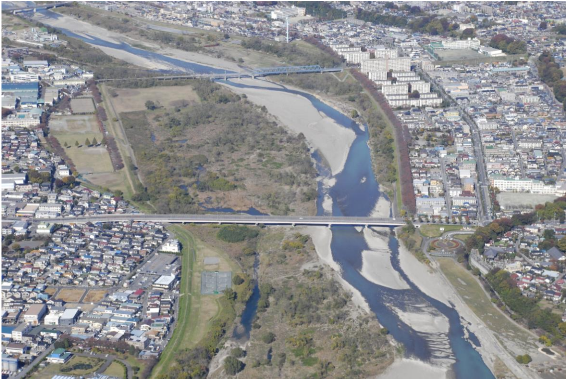
河口から 49km 付近
