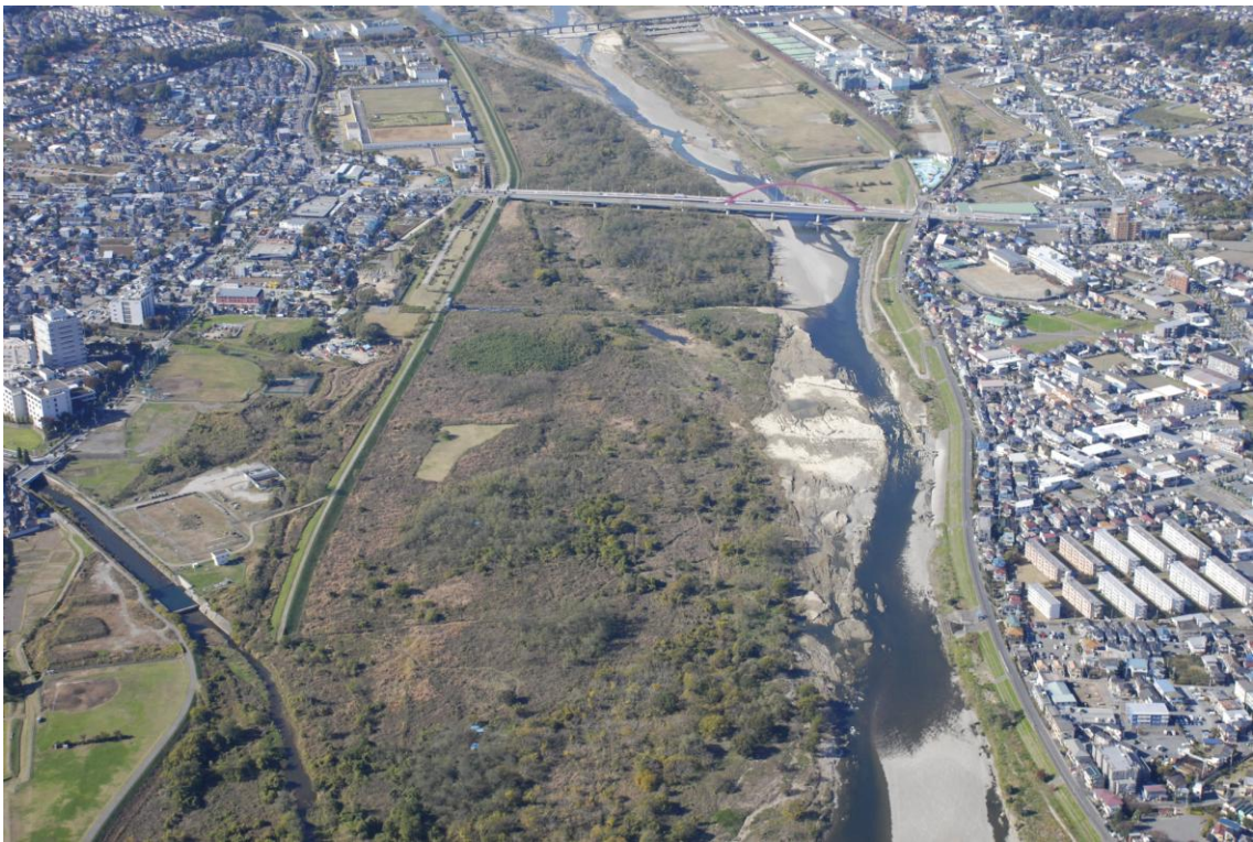
河口から 43km 付近
