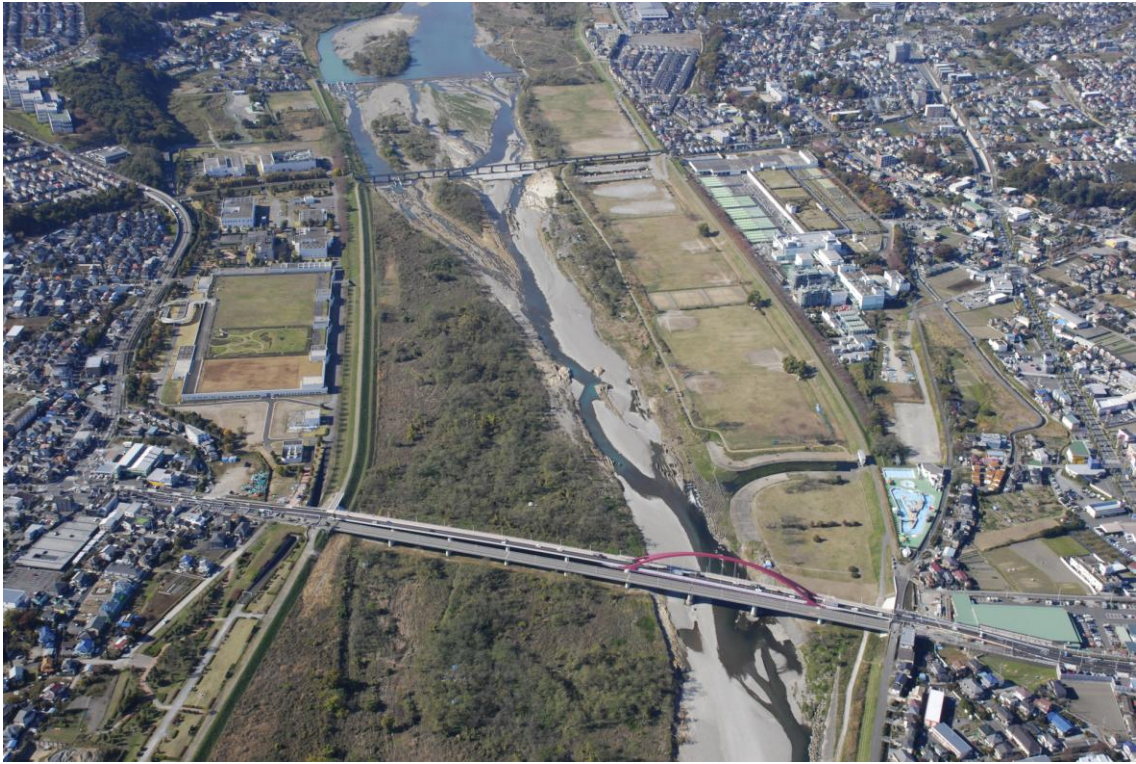
河口から 44km 付近
