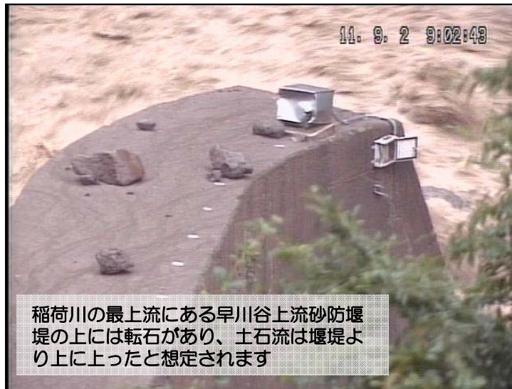
稲荷川第10上流砂防堰堤の土砂堆積（平成23年9月2日）
