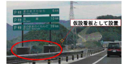
図一道の駅(路外施設)への誘導案内を道路上に設置している例(鳥取自動車道)
