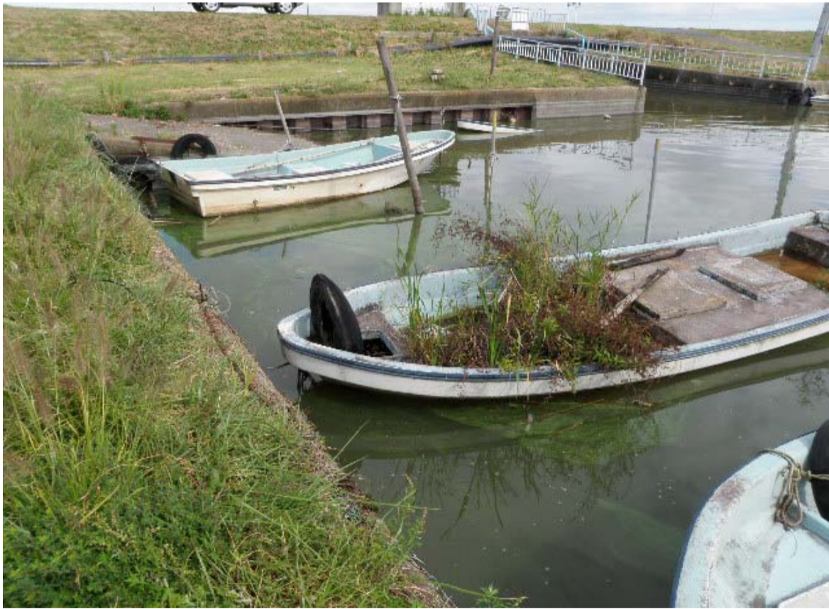
西浦中岸30.75km-80m(高賀津舟溜り)
